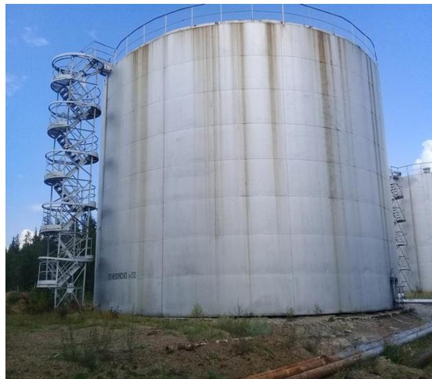
Рисунок 1 - Общий вид резервуара РВС-2000
