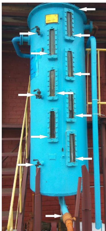
Рисунок 2 - Схема пломбировки мерника вертикального шкального типа ТЦКС-75 зав. № 29 от несанкционированного доступа, обозначение места нанесения знака поверки
