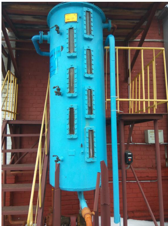
Рисунок 1 - Общий вид мерника ТЦКС-75 зав. № 29
