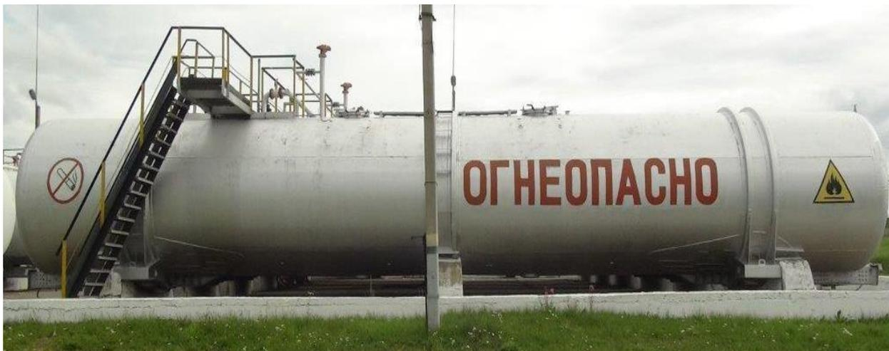
Рисунок 1 - Общий вид резервуара стального горизонтального цилиндрического РГС-137
