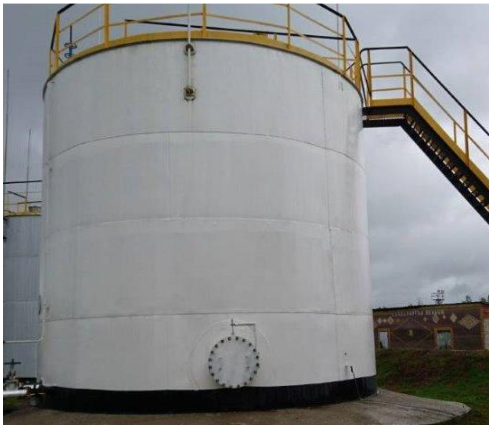
Рисунок 1 - Общий вид резервуара стального вертикального цилиндрического РВС-200
