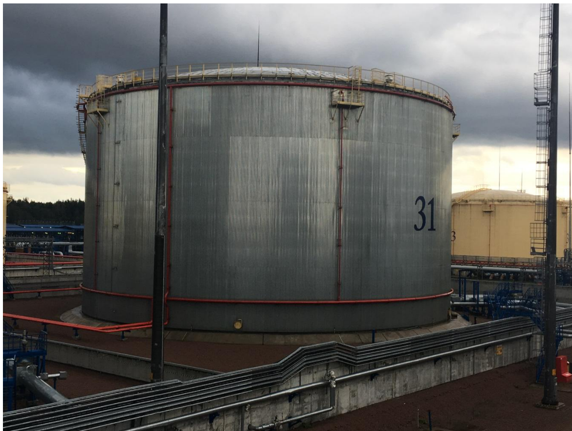
Рисунок 1 - Общий вид резервуара РВС-40000
