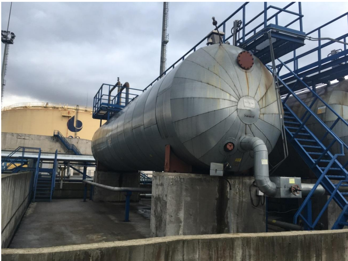
Рисунок 1 - Общий вид резервуара РГС-100
