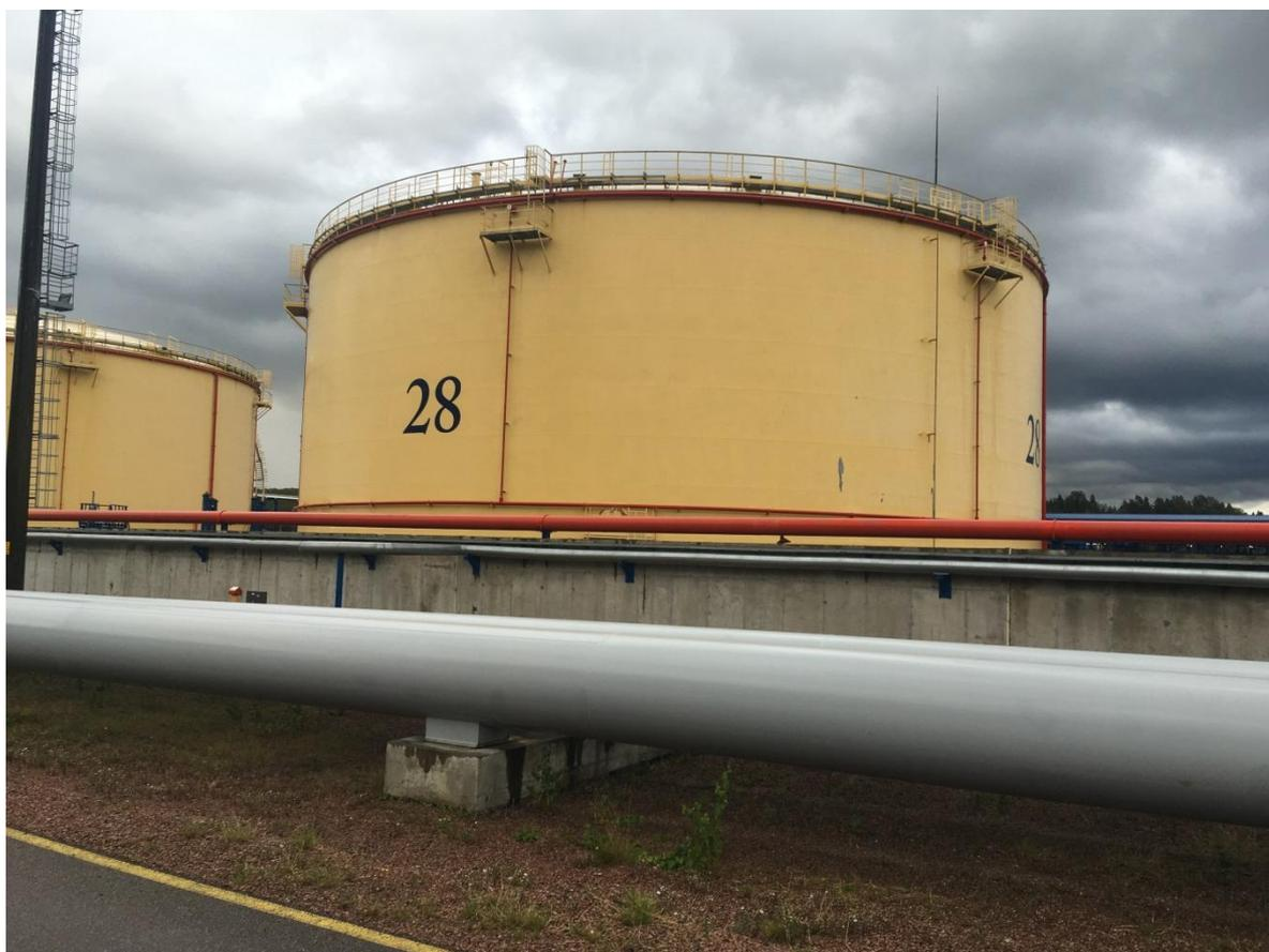
Рисунок 1 - Общий вид резервуара РВСП-30000
