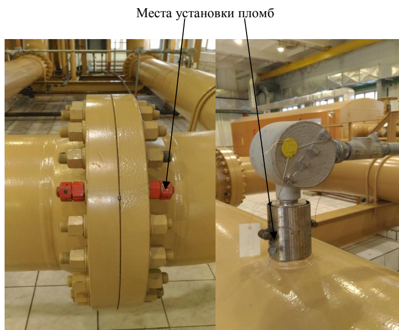
Рисунок 2 – Схема пломбировки от несанкционированного доступа, обозначение места нанесения знака поверки
