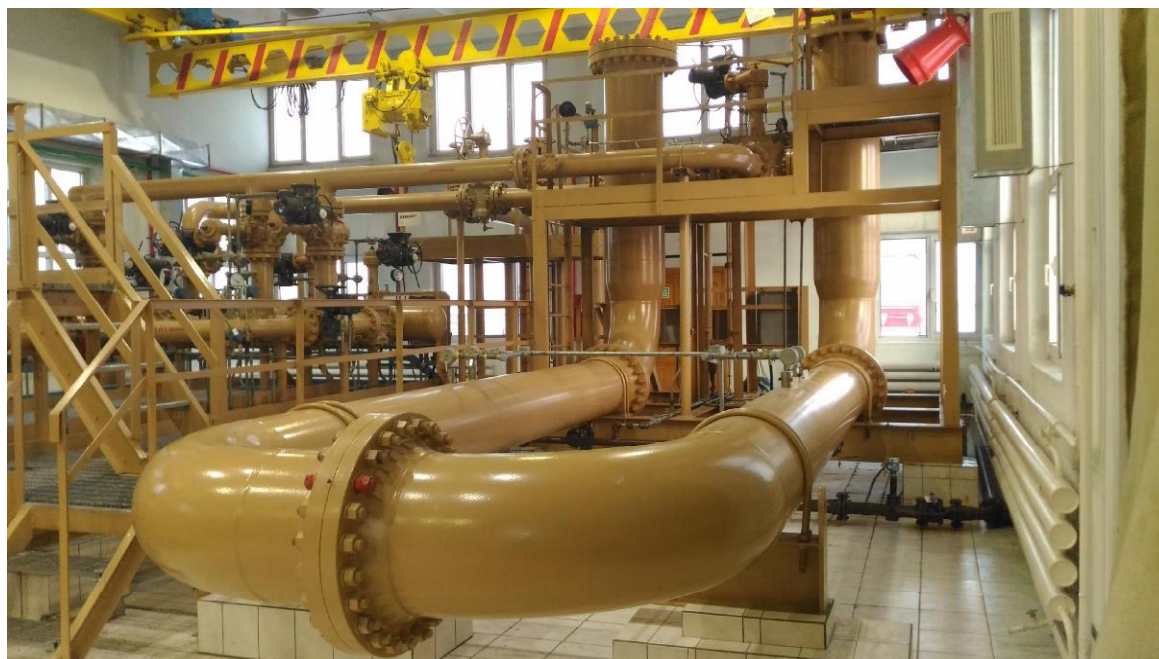
Рисунок 1 – Общий вид установки поверочной трубопоршневой двунаправленной Smith-1100
