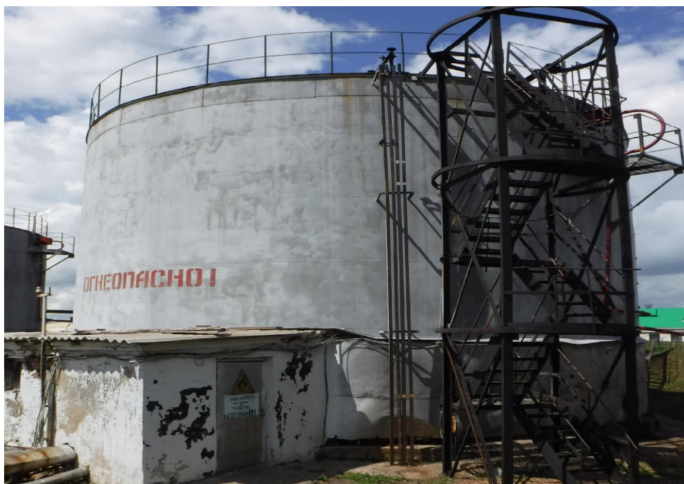
Рисунок 1 - Общий вид резервуара РВС-1000
