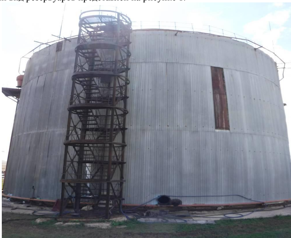
Рисунок 1 - Общий вид резервуара РВС-5000
