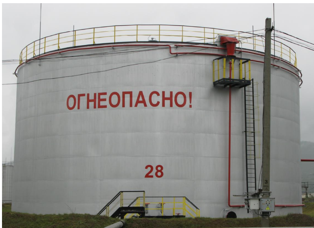
Рисунок 7 - Общий вид резервуара стального вертикального цилиндрического РВС-5000
