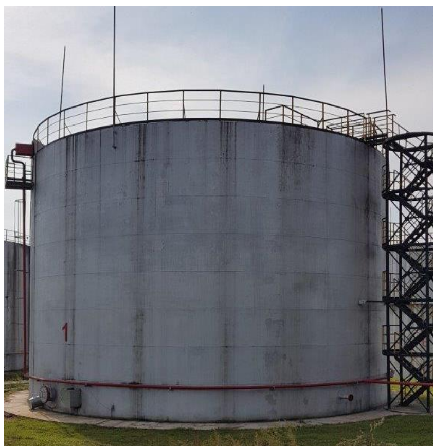
Рисунок 6 - Общий вид резервуара стального вертикального цилиндрического РВС-3000
