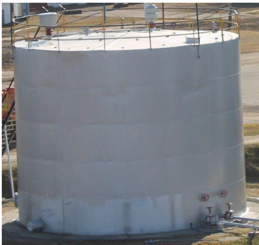
Рисунок 2 - Общий вид резервуара стального вертикального цилиндрического РВС-400
