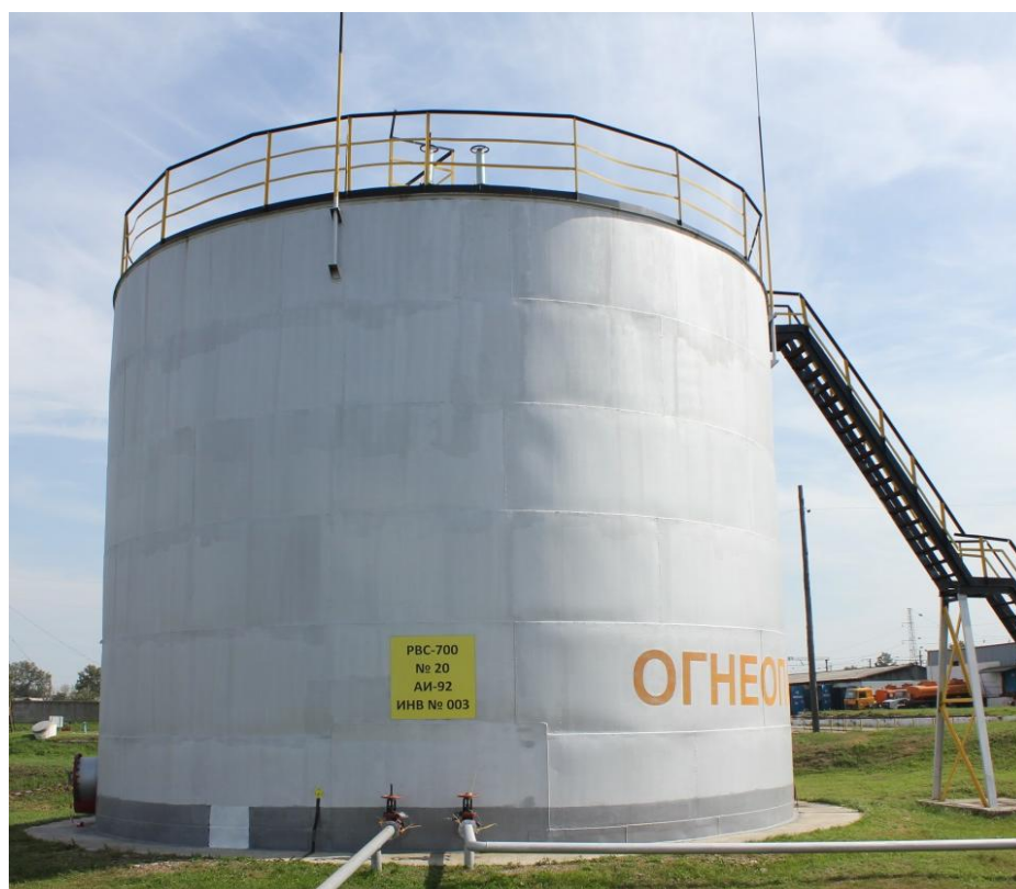
Рисунок 3 - Общий вид резервуара стального вертикального цилиндрического РВС-700
