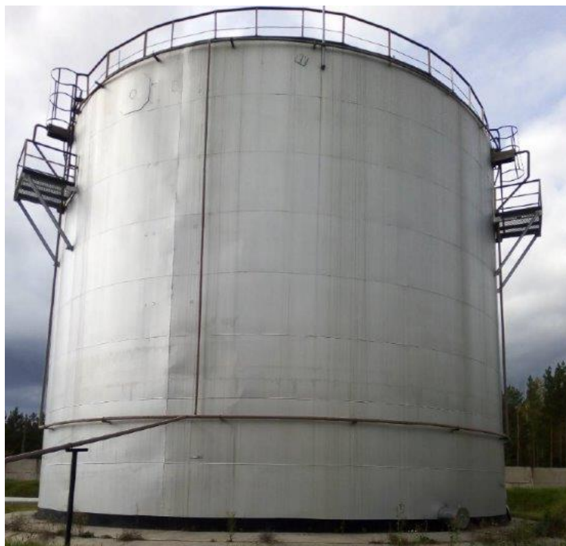
Рисунок 5 - Общий вид резервуара стального вертикального цилиндрического РВС-2000
