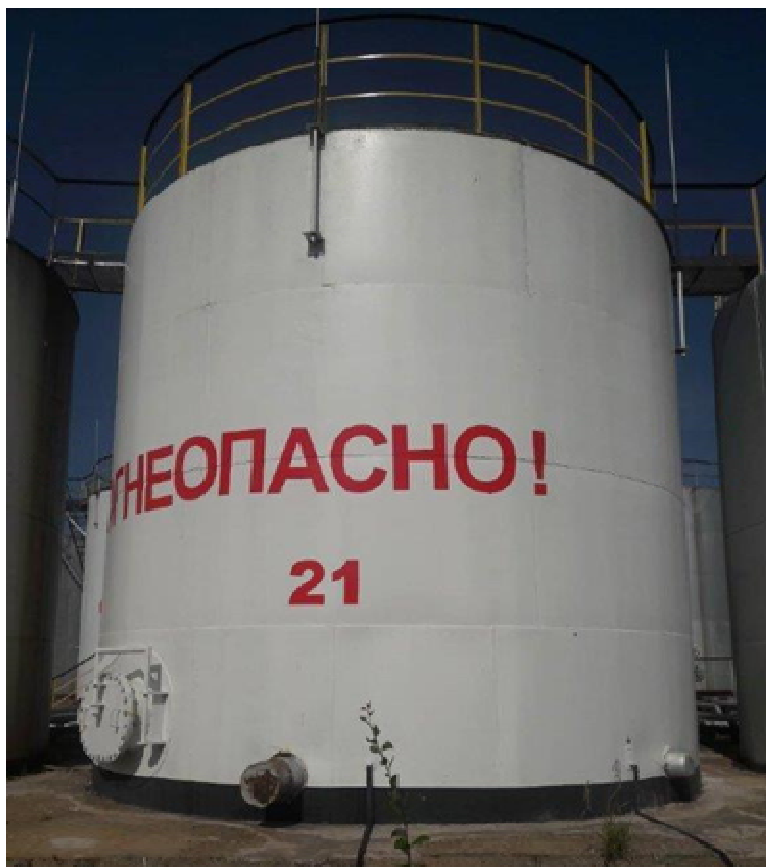
Рисунок 1 - Общий вид резервуара стального вертикального цилиндрического РВС-200
