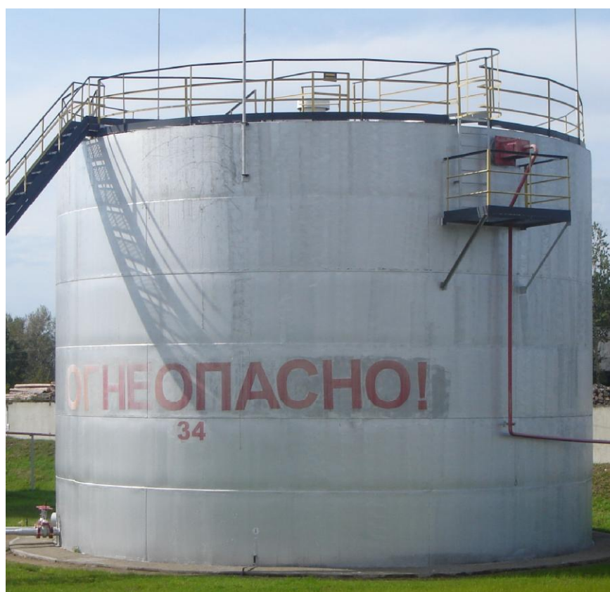
Рисунок 4 - Общий вид резервуара стального вертикального цилиндрического РВС-1000
