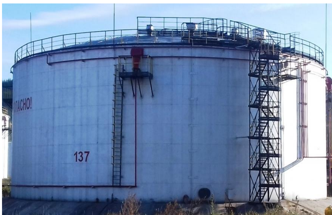
Рисунок 8 - Общий вид резервуара стального вертикального цилиндрического РВС-10000
