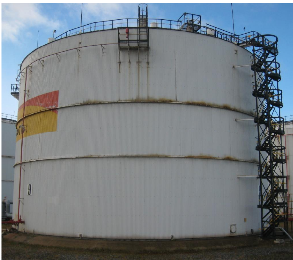
Рисунок 1 - Общий вид резервуара стального вертикального цилиндрического РВСП-10000
