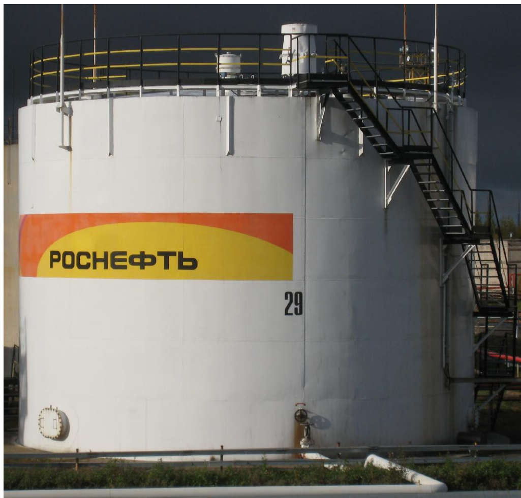
Рисунок 1 - Общий вид резервуара стального вертикального цилиндрического РВС-1000
