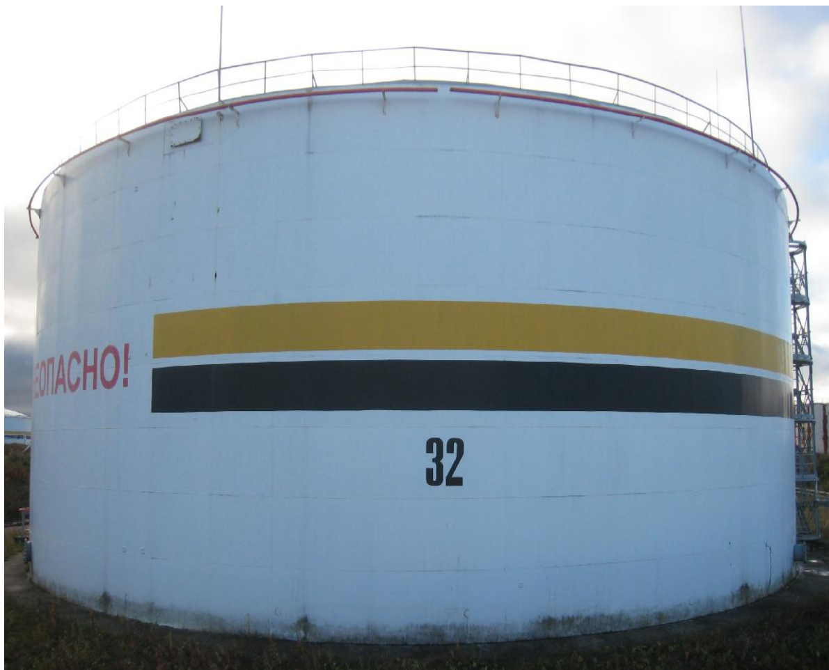
Рисунок 2 - Общий вид резервуара стального вертикального цилиндрического РВС-10000
