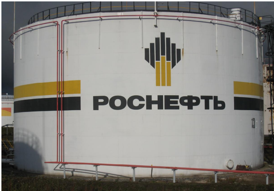
Рисунок 1 - Общий вид резервуара стального вертикального цилиндрического РВС-5000
