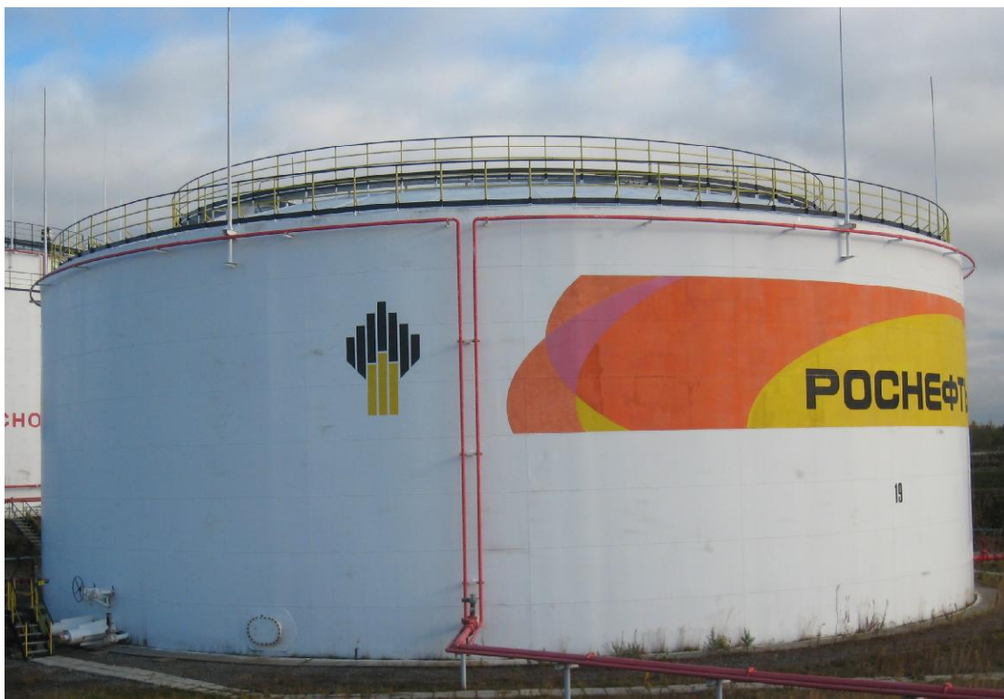
Рисунок 2 - Общий вид резервуара стального вертикального цилиндрического РВС-10000
