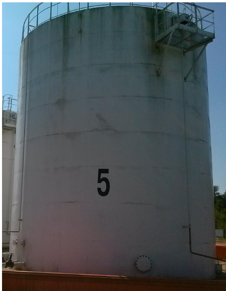
Рисунок 1 - Общий вид резервуара стального вертикального цилиндрического РВС-1000
