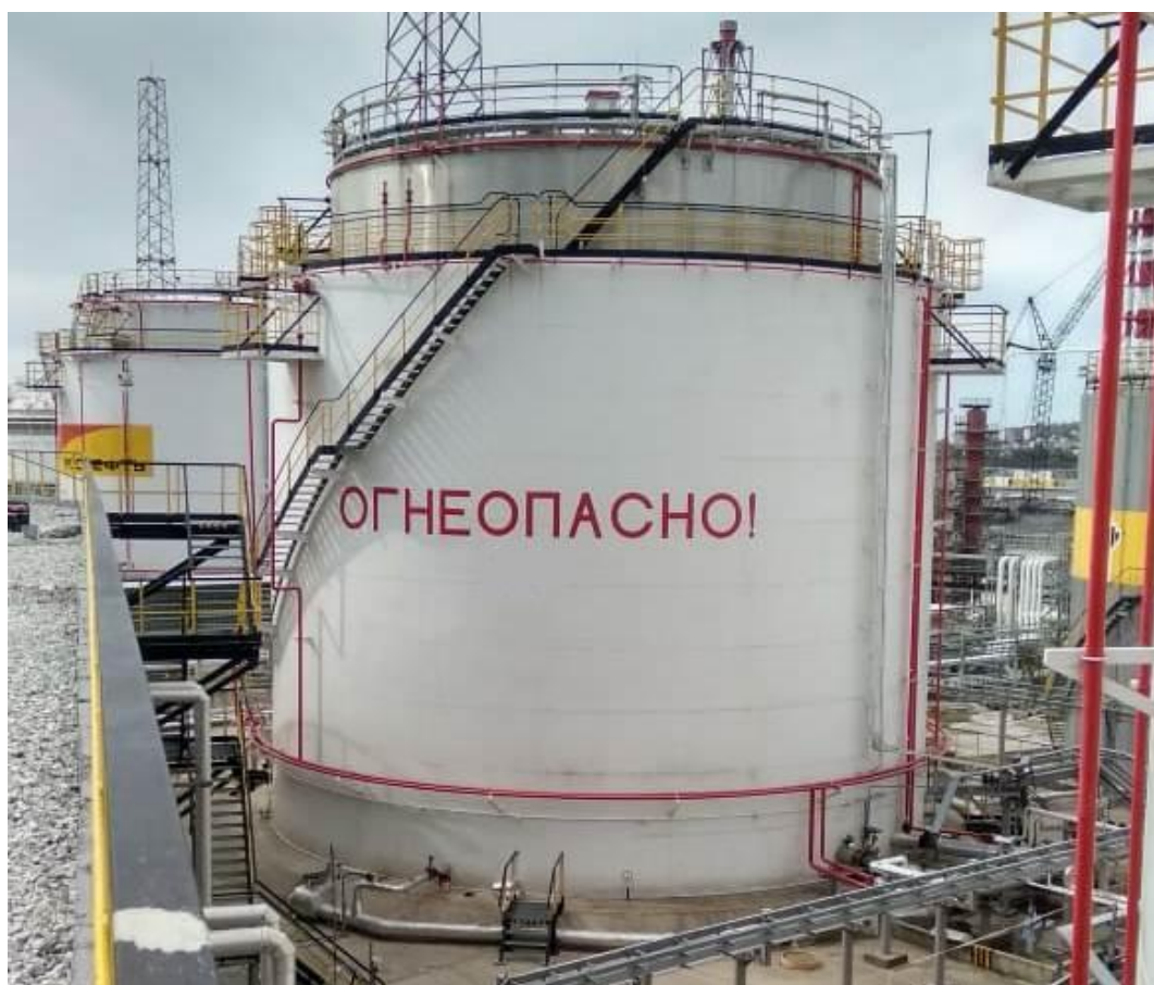
Рисунок 1 - Общий вид резервуаров РВС-3000
