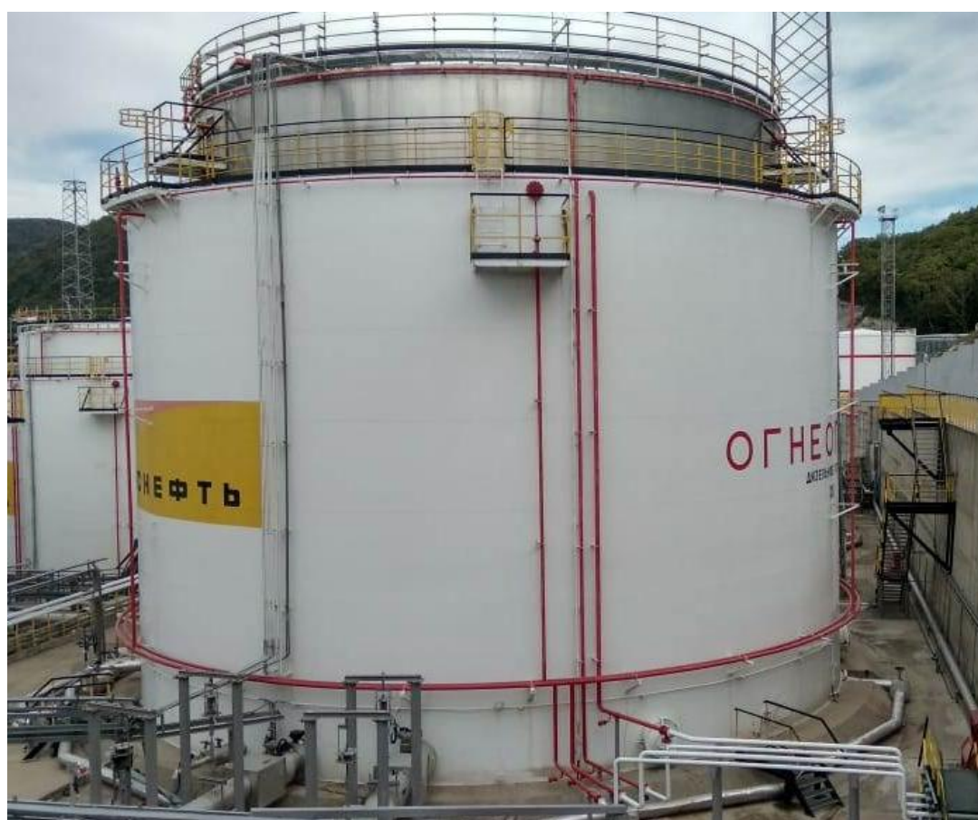
Рисунок 2 - Общий вид резервуаров РВС-5000
