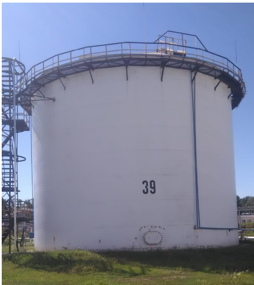
Рисунок 2 - Общий вид резервуара РВС-2000 №39
