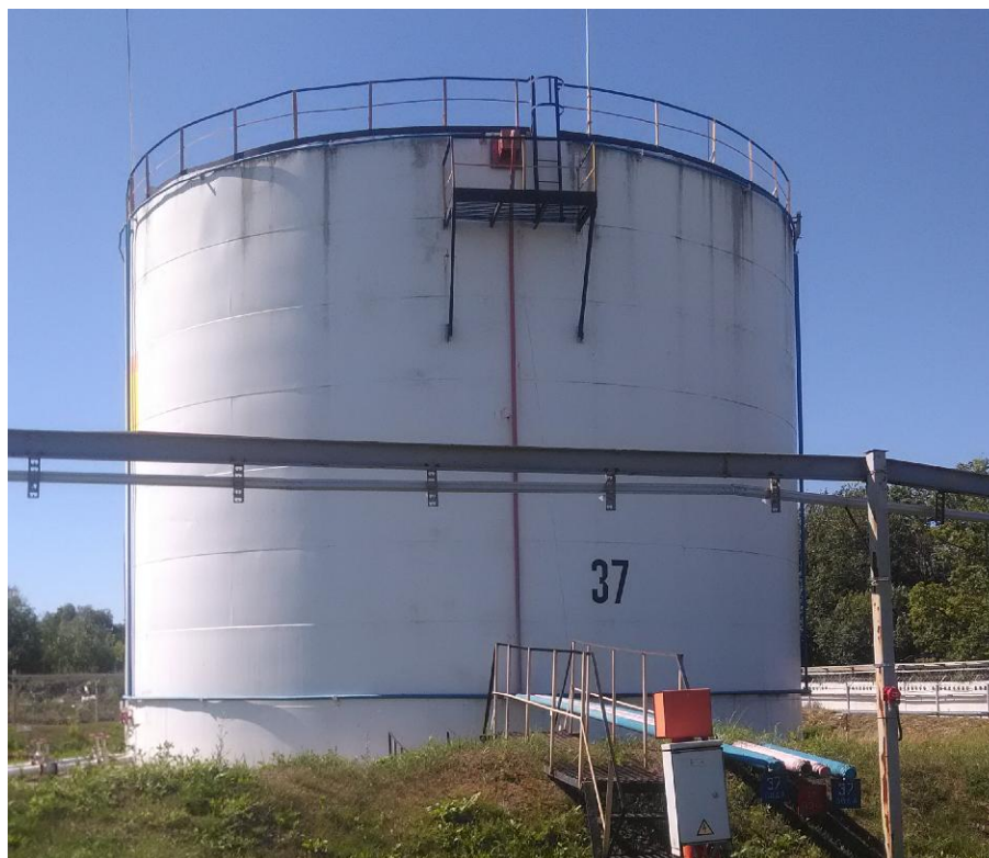
Рисунок 1 - Общий вид резервуара РВС-2000 №37
