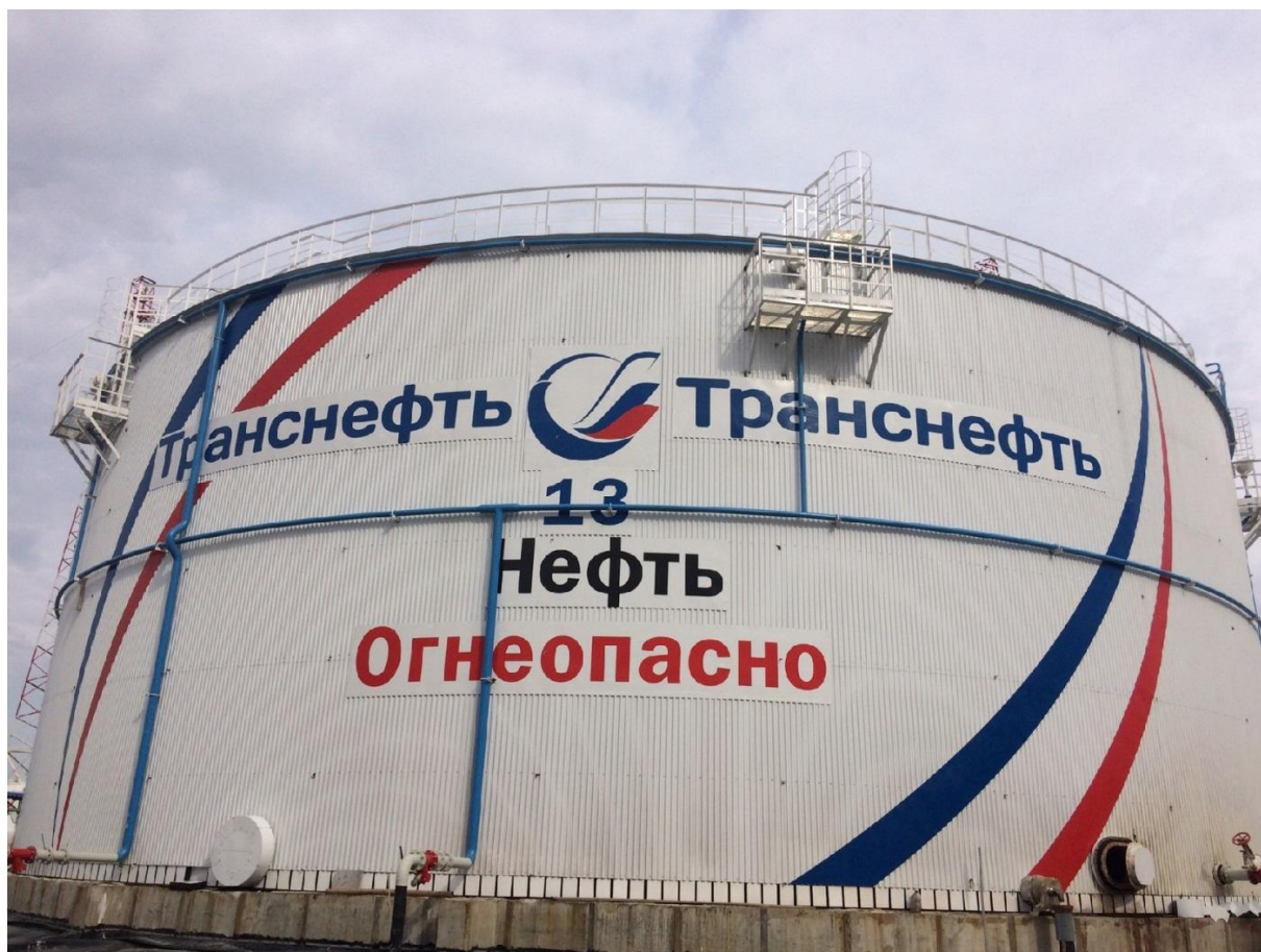
Рисунок 1 - Общий вид резервуара РВС-10000
