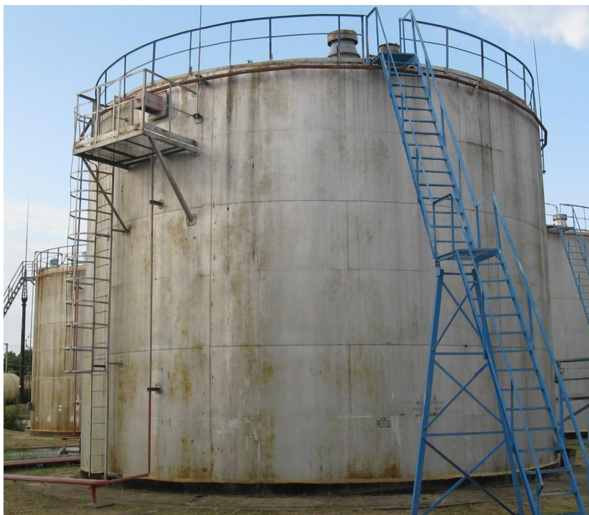
Рисунок 1 - Резервуар стальной вертикальный цилиндрический с понтоном РВСП-1000
