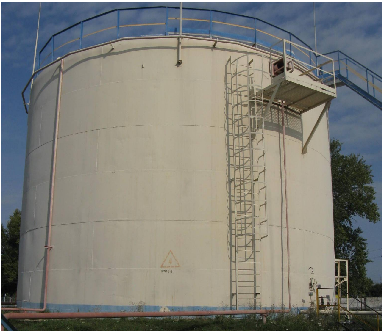
Рисунок 1 - Резервуар стальной вертикальный цилиндрический с понтоном РВСП-1000
