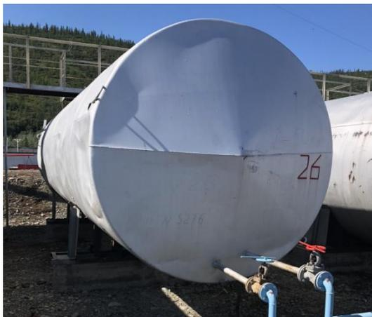
Рисунок 1 - Общий вид резервуаров стальных горизонтальных цилиндрических РГС-50
