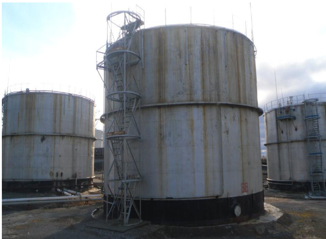
Рисунок 3 - Общий вид резервуара РВС-2000
