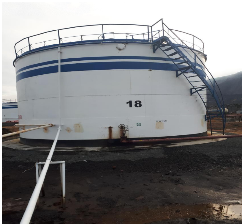
Рисунок 1 - Общий вид резервуара РВС-700
