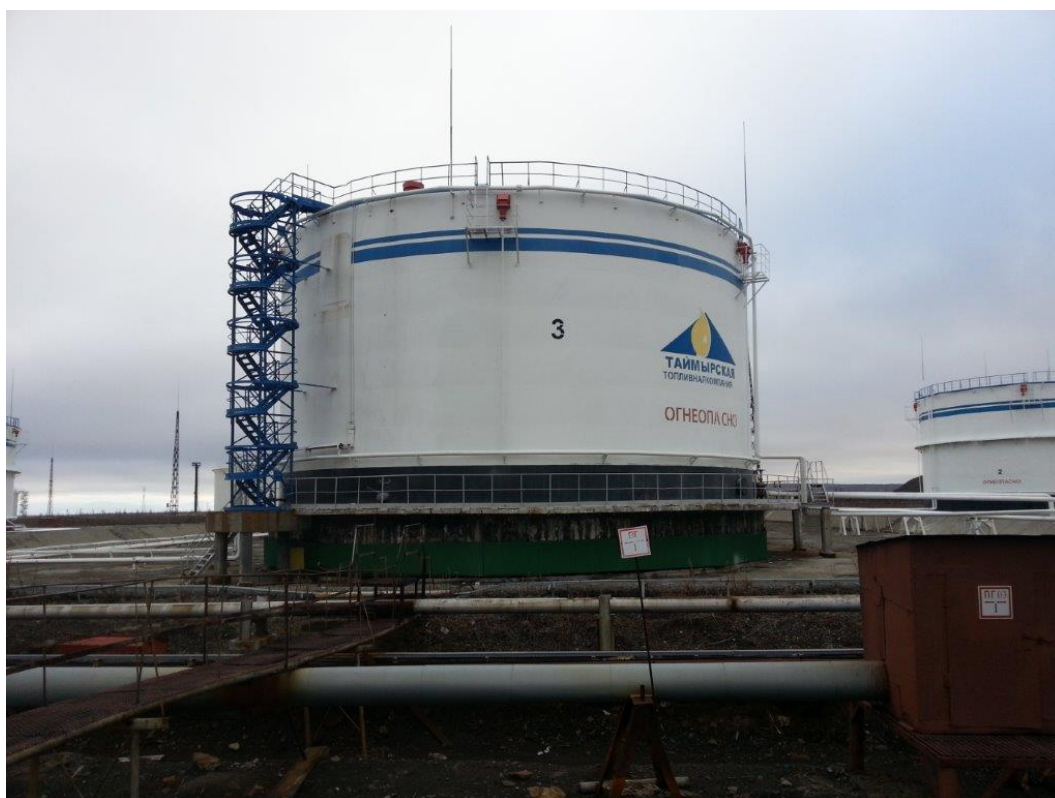
Рисунок 4 - Общий вид резервуара РВС-5000
