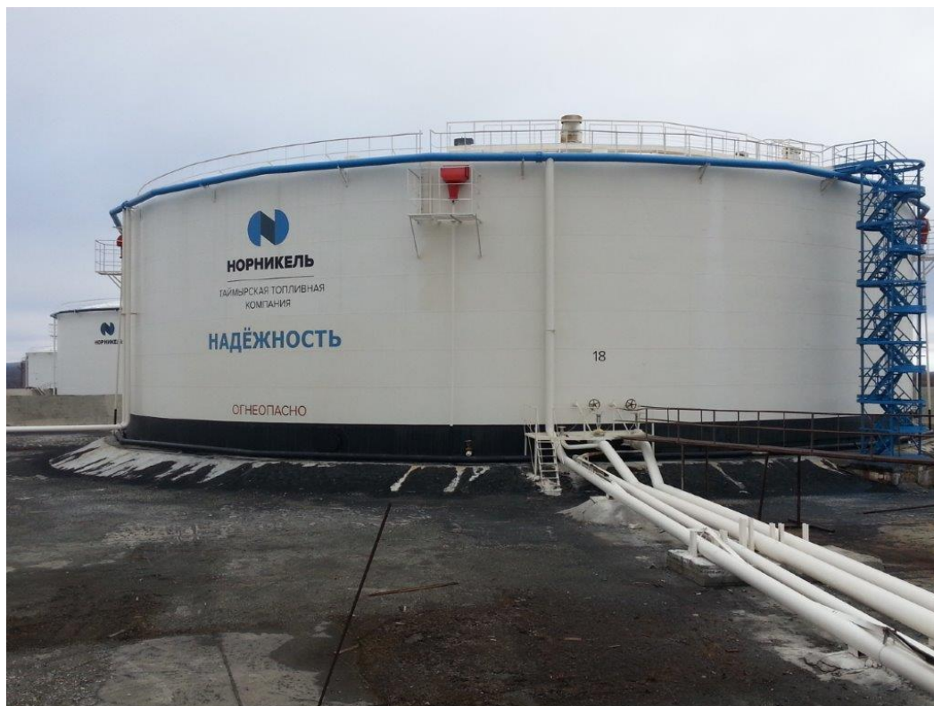
Рисунок 5 - Общий вид резервуара РВС-20000
