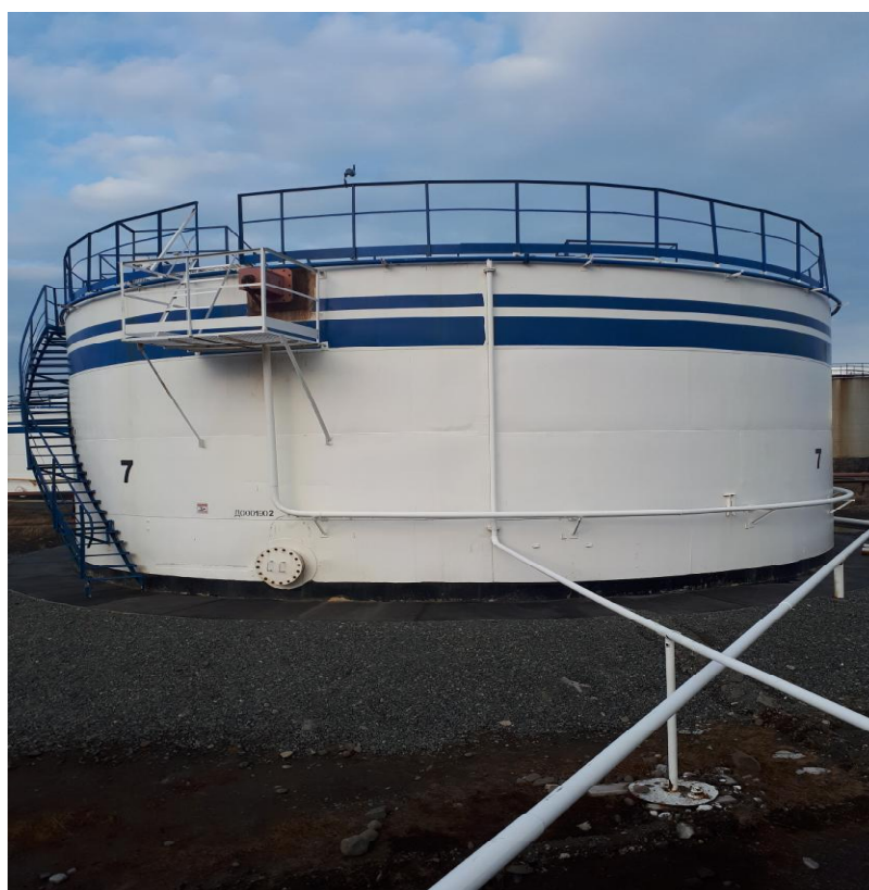
Рисунок 2 - Общий вид резервуара РВС-1000
