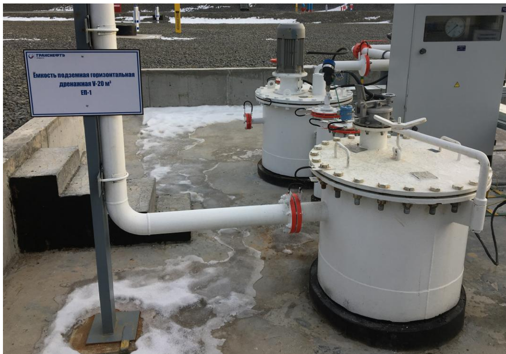
Рисунок 1 - Общий вид места установки резервуара стального горизонтального цилиндрического РГС-20 зав. № 77
