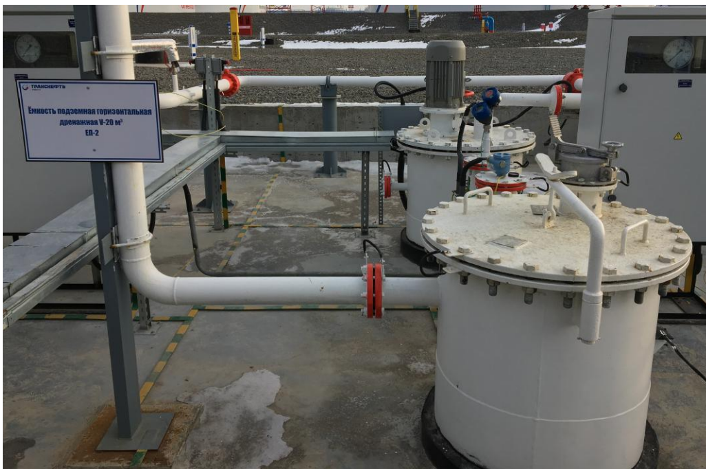
Рисунок 2 - Общий вид места установки резервуара стального горизонтального цилиндрического РГС-20 зав. № 78
