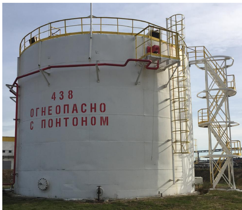
Рисунок 5 - Общий вид резервуара стального вертикального цилиндрического РВС-1000, РВСП-1000
