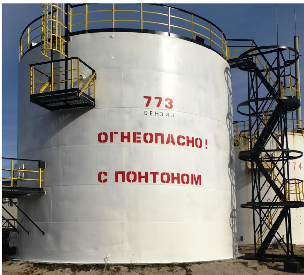
Рисунок 4 - Общий вид резервуара стального вертикального цилиндрического РВСП-700
