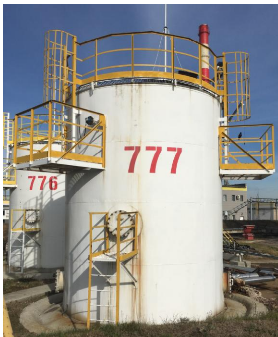
Рисунок 1 - Общий вид резервуара стального вертикального цилиндрического РВСП-100
