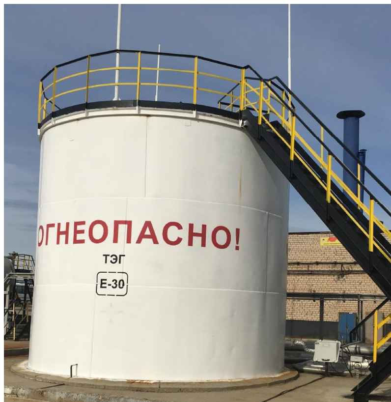
Рисунок 2 - Общий вид резервуара стального вертикального цилиндрического РВС-200
