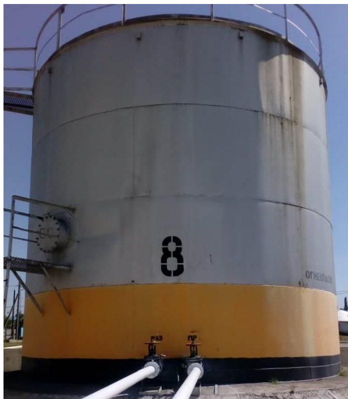
Рисунок 1 - Общий вид резервуара стального вертикального цилиндрического РВС-200
