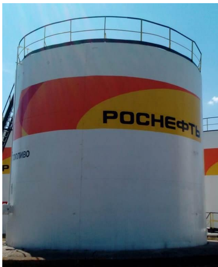
Рисунок 2 - Общий вид резервуара стального вертикального цилиндрического РВС-700
