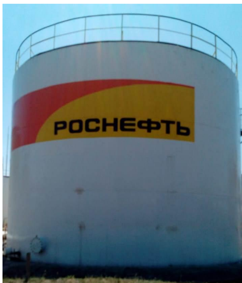
Рисунок 3 - Общий вид резервуара стального вертикального цилиндрического РВС-1000
