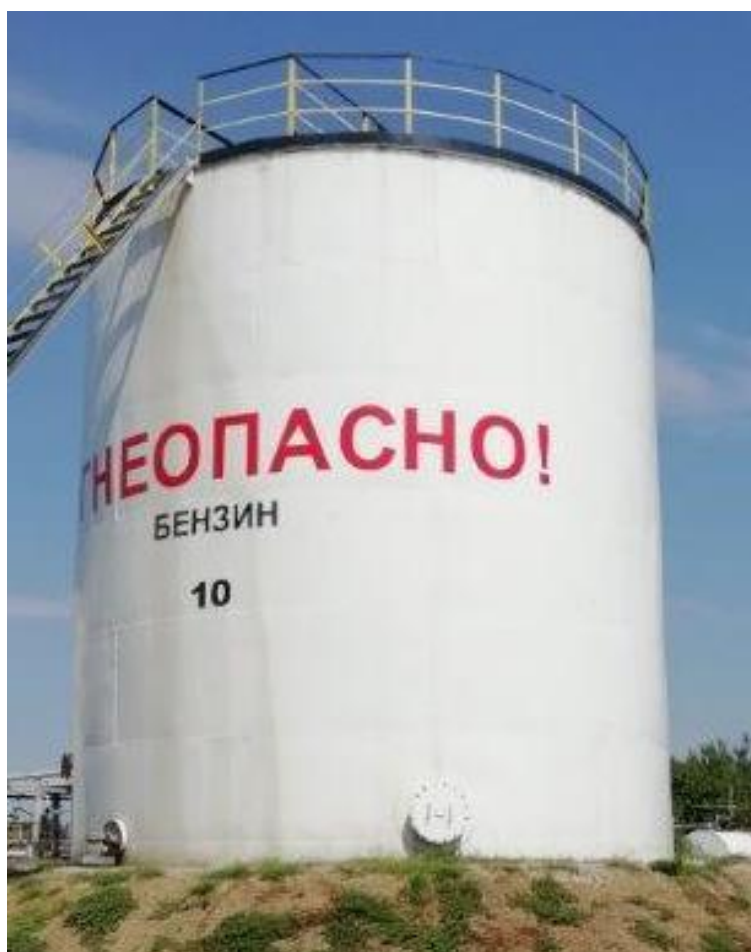
Рисунок 1 - Общий вид резервуара стального вертикального цилиндрического РВС-400
