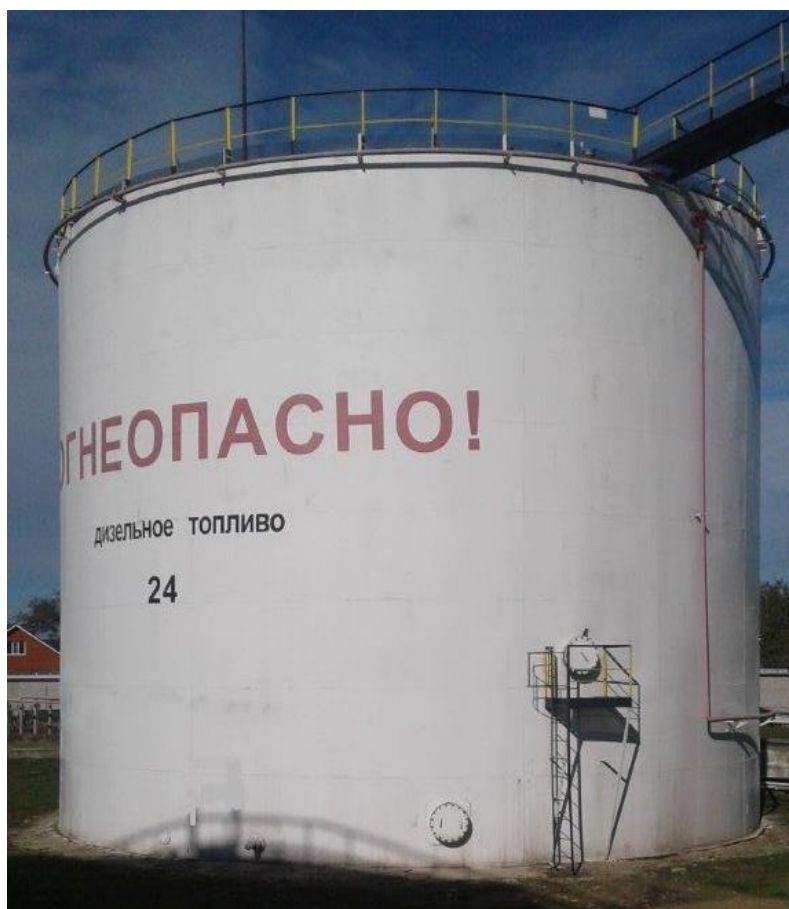
Рисунок 4 - Общий вид резервуара стального вертикального цилиндрического РВС-2000
