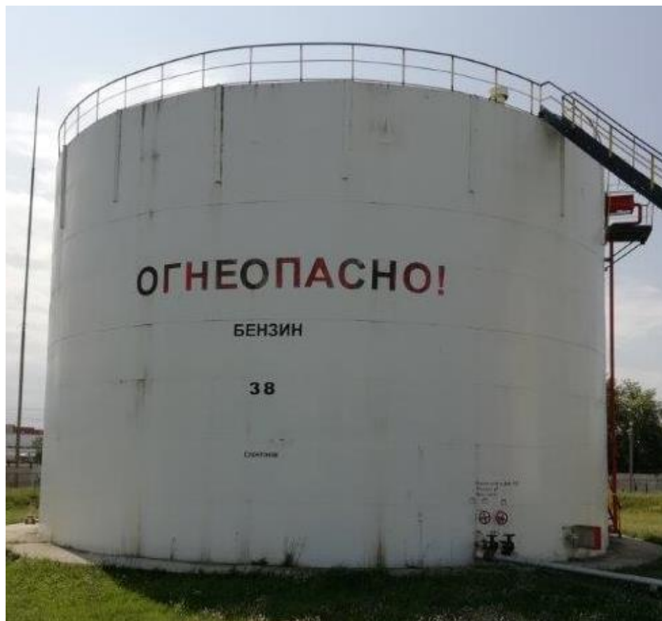
Рисунок 5 - Общий вид резервуара стального вертикального цилиндрического PVC-3000
