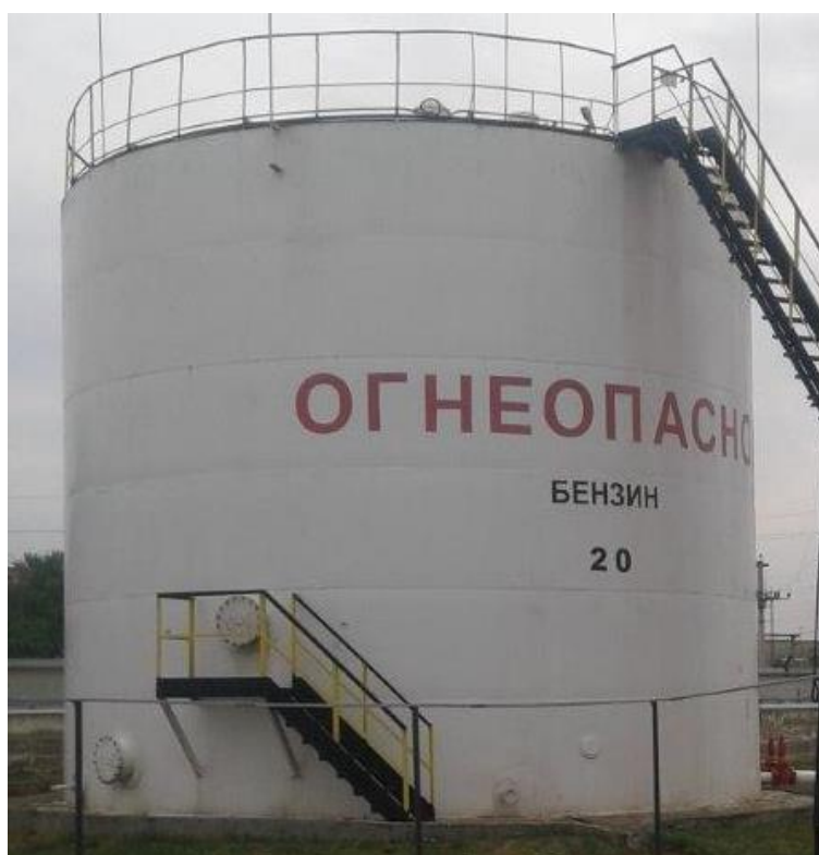
Рисунок 2 - Общий вид резервуара стального вертикального цилиндрического РВС-700
