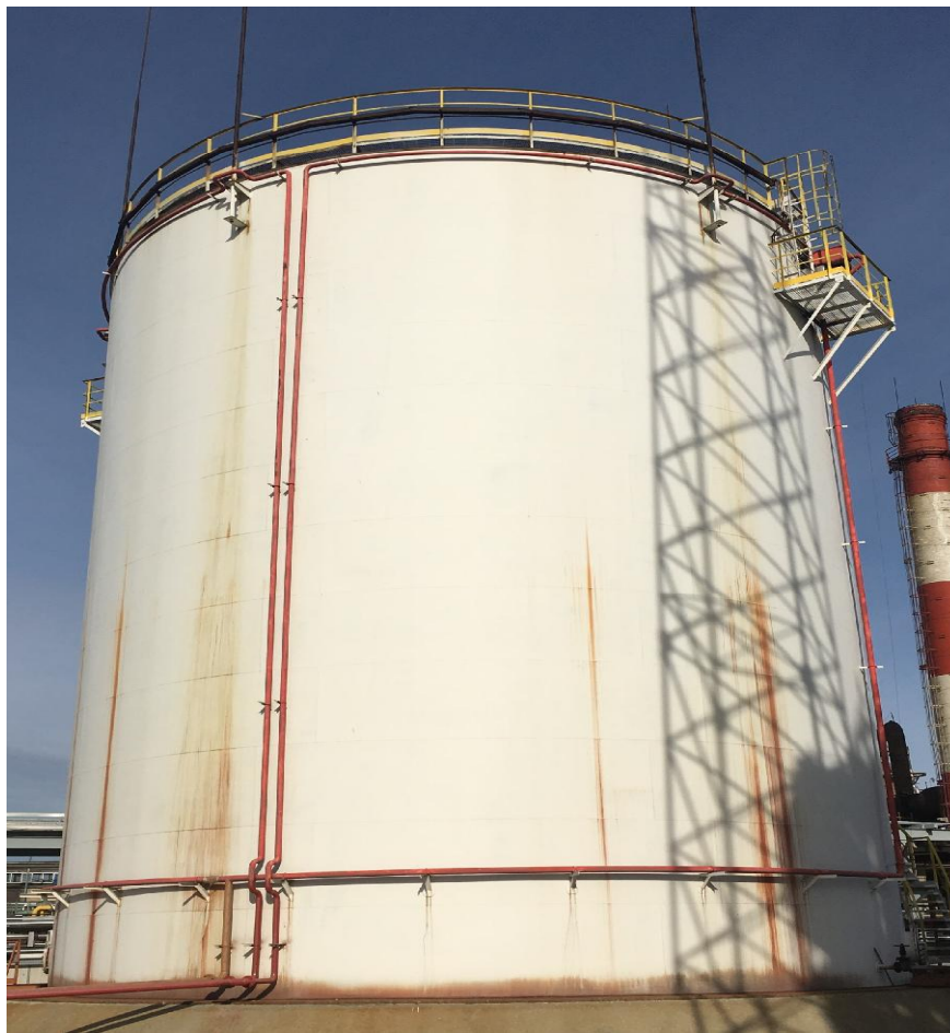
Рисунок 2 - Общий вид резервуара стального вертикального цилиндрического РВС-3000, РВСП-3000
