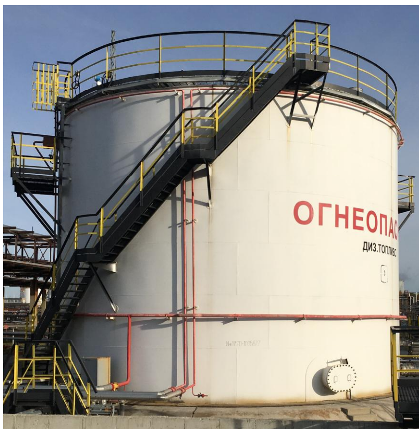
Рисунок 1 - Общий вид резервуара стального вертикального цилиндрического РВС-1000
