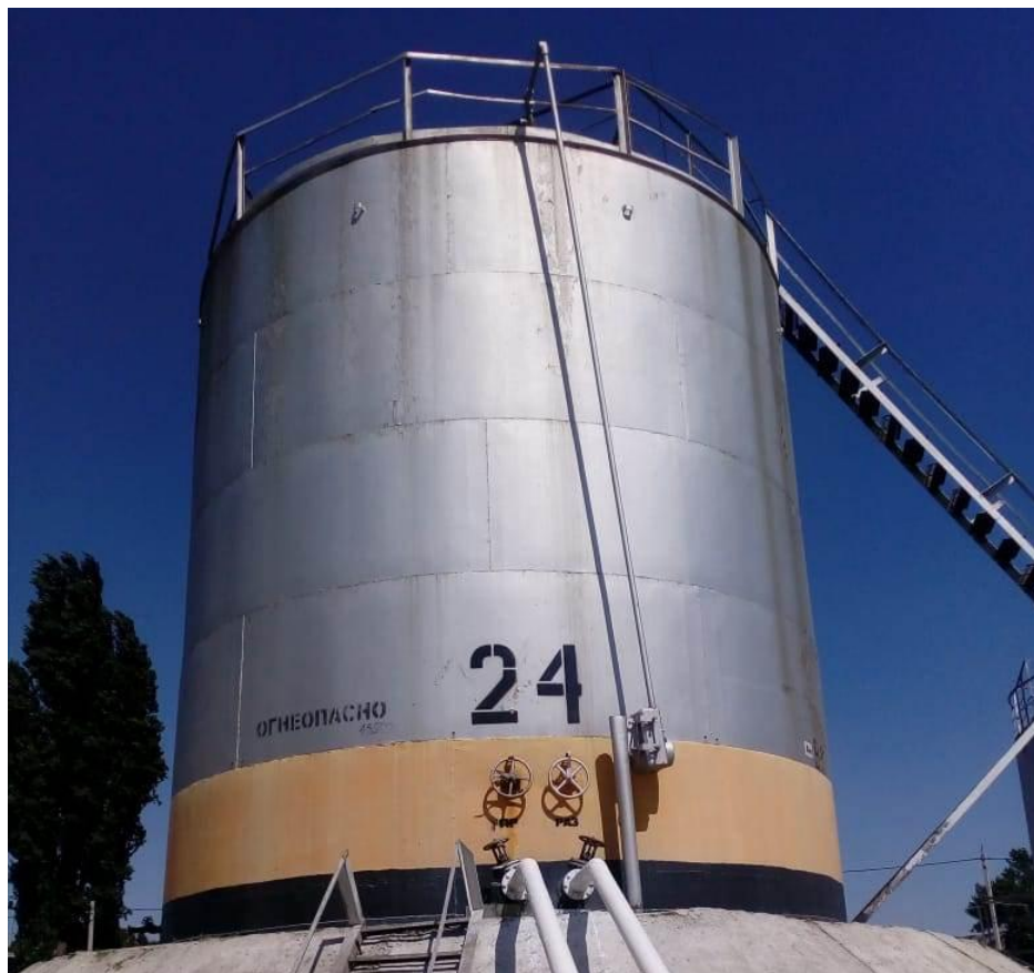
Рисунок 1 - Общий вид резервуара стального вертикального цилиндрического РВС-200
