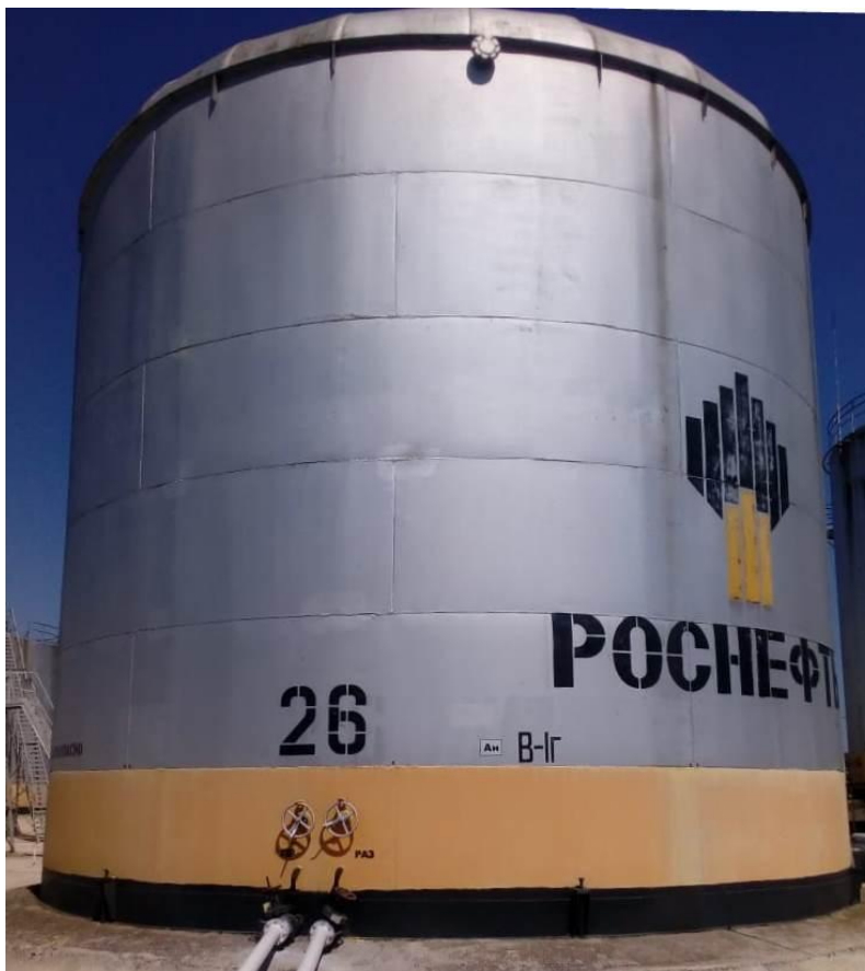
Рисунок 3 - Общий вид резервуара стального вертикального цилиндрического РВС-700
