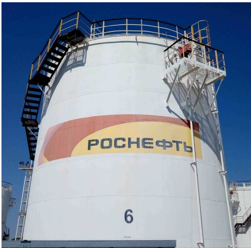
Рисунок 1 - Общий вид резервуара стального вертикального цилиндрического РВС-1000
