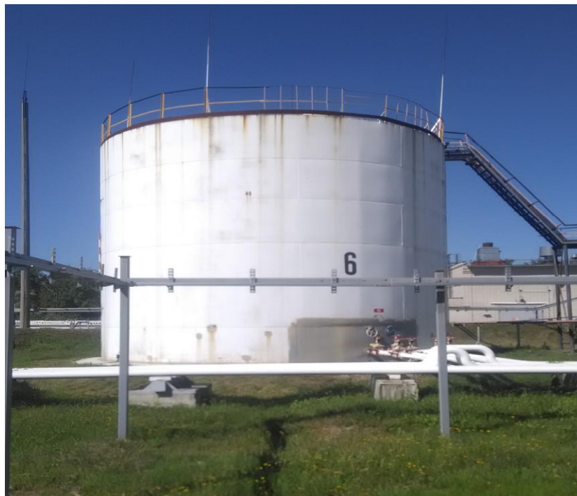
Рисунок 1 - Общий вид резервуара
