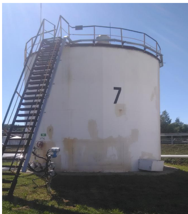
Рисунок 1 - Общий вид резервуара РВС-200
