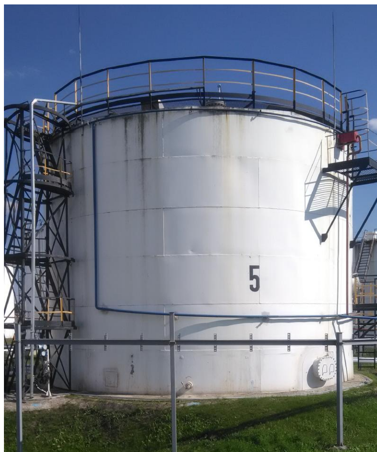
Рисунок 2 - Общий вид резервуара РВСП-1000 № 5
