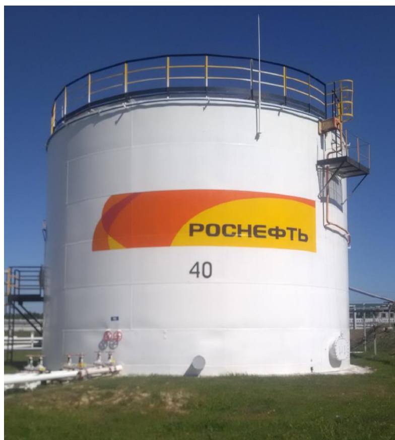
Рисунок 3 - Общий вид резервуара РВСП-1000 № 40
