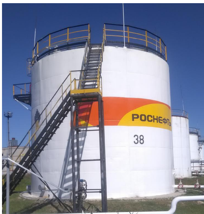
Рисунок 1 - Общий вид резервуара РВСП-700 № 38
