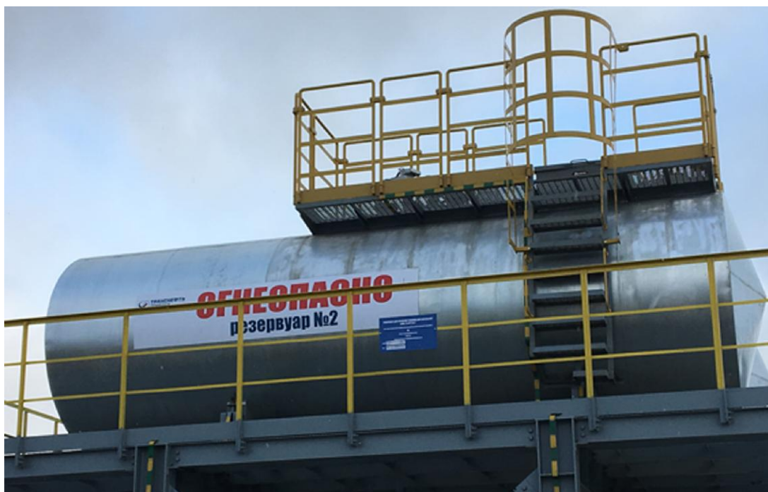
Рисунок 2 - Общий вид резервуара стального горизонтального цилиндрического РГС-20 зав. № 314
