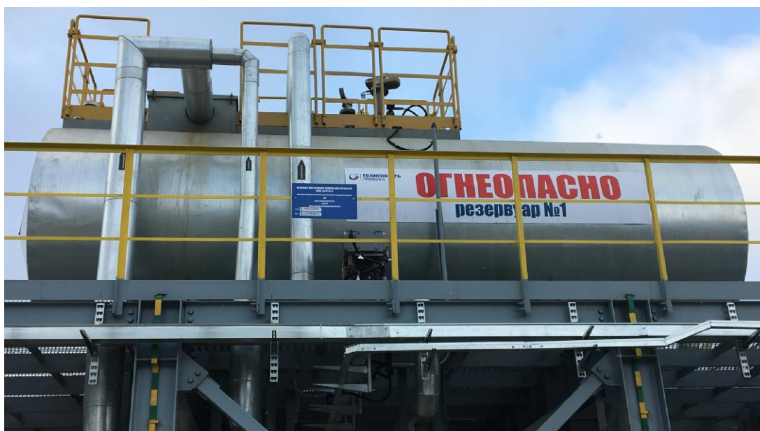
Рисунок 1 - Общий вид резервуара стального горизонтального цилиндрического РГС-20 зав. № 313
