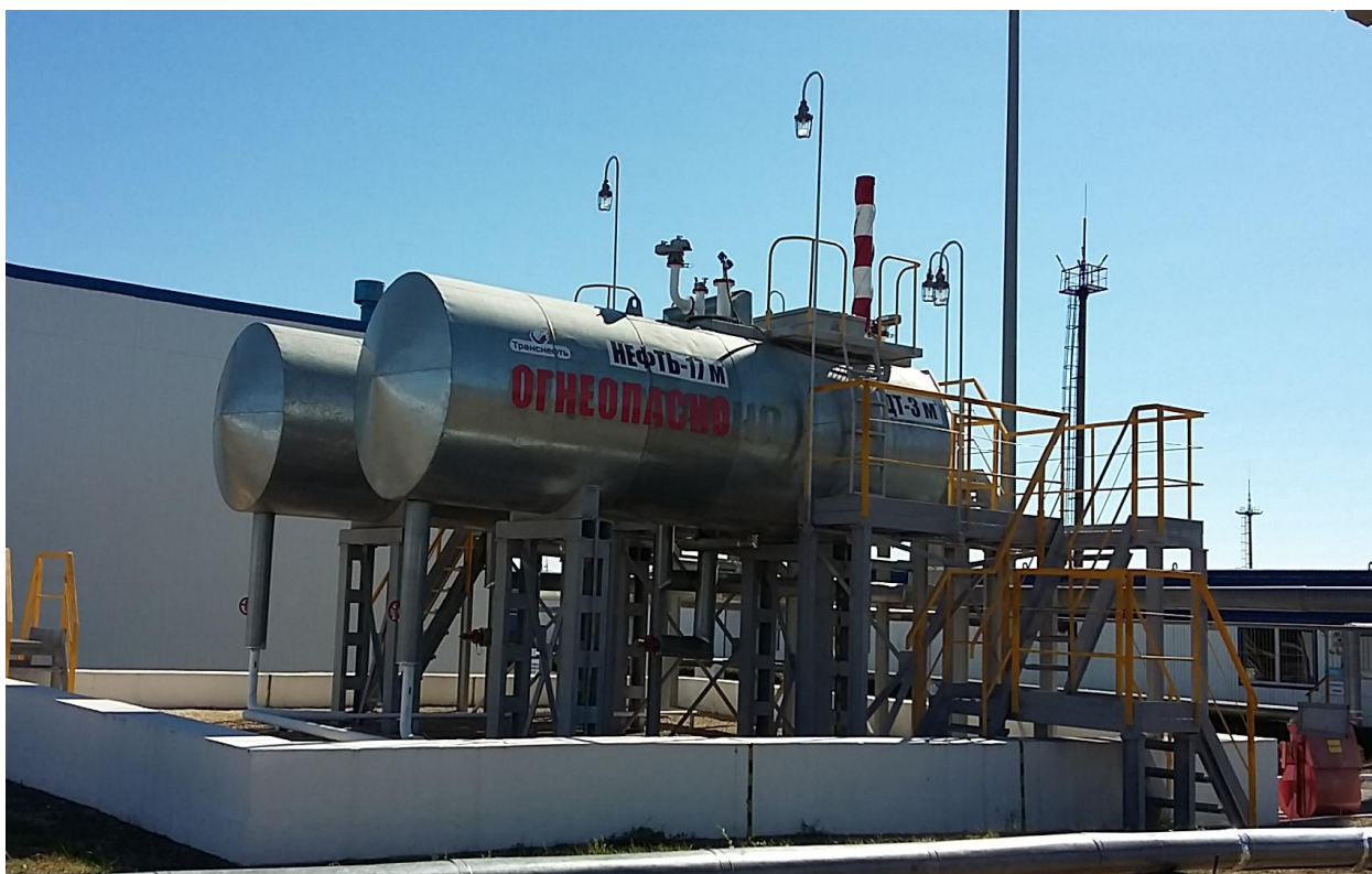
Рисунок 2 - Общий вид резервуаров РГС-20 №№ 171, 180
