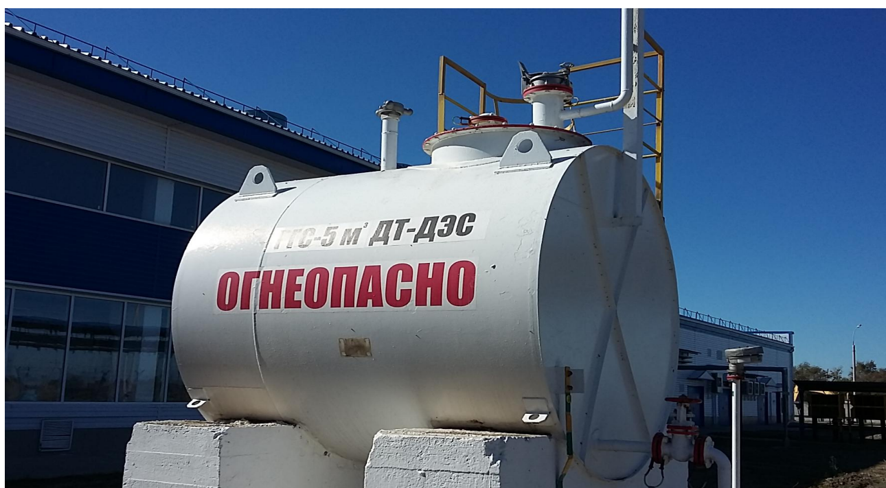
Рисунок 1 - Общий вид резервуара РГС-5 №108
