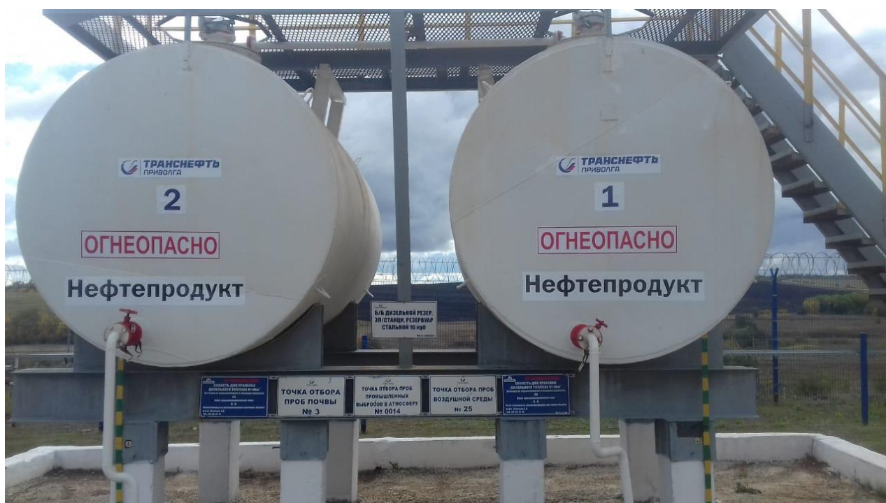
Рисунок 2 - Общий вид резервуаров РГС-10 №№1, 2 (БКНС «Бугуруслан»)
