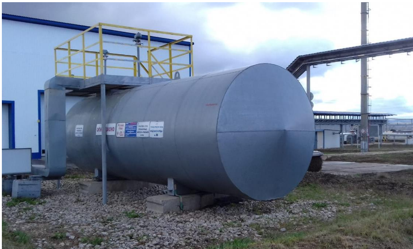
Рисунок 1 - Общий вид резервуара РГС-20 № 88
