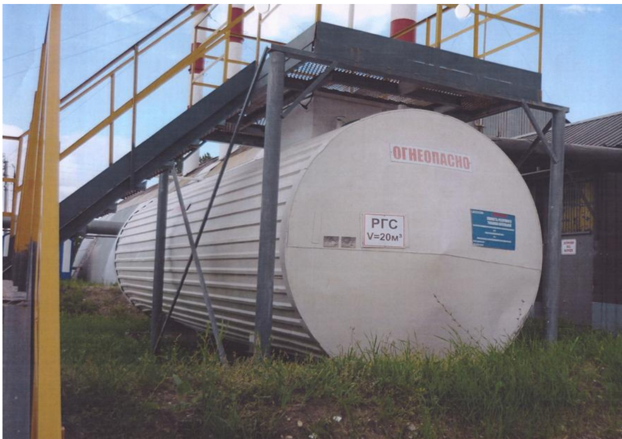
Рисунок 3 - Общий вид резервуара РГС-20 №6399 36/36
