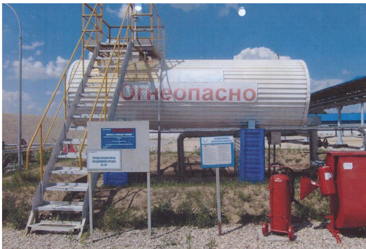
Рисунок 4 - Общий вид резервуара РГС-20 № 3
