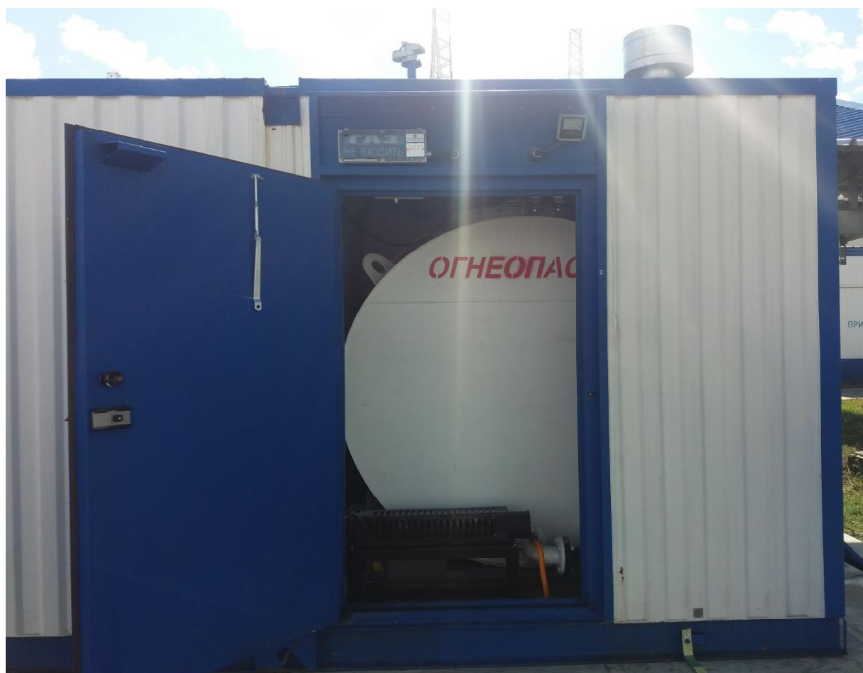
Рисунок 3 - Общий вид резервуара №3
