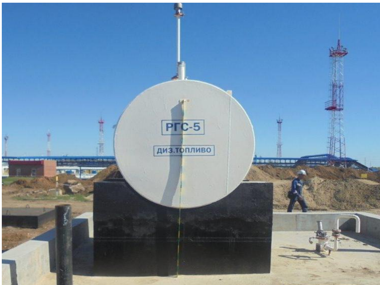
Рисунок 1 - Общий вид резервуара № 1
