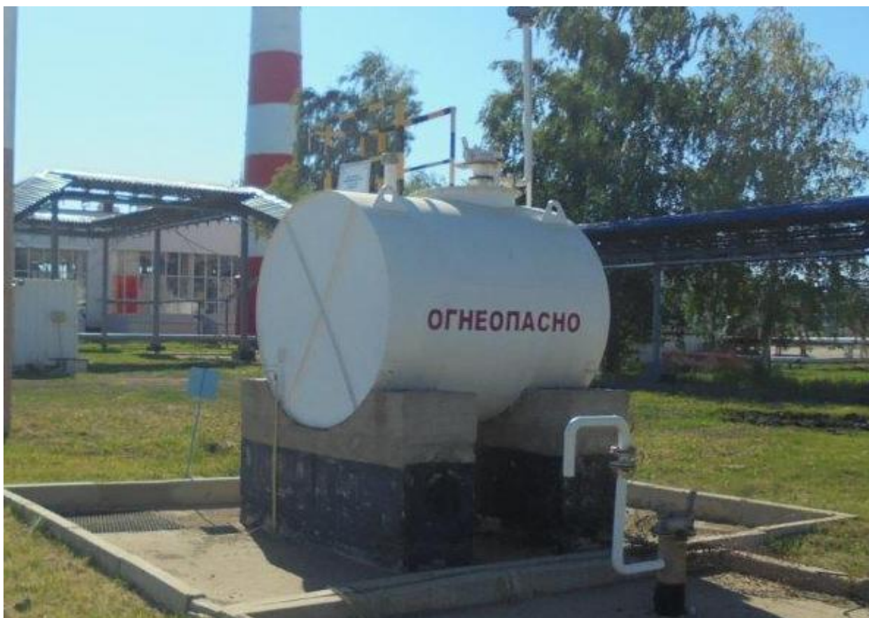
Рисунок 2 - Общий вид резервуара № 2
