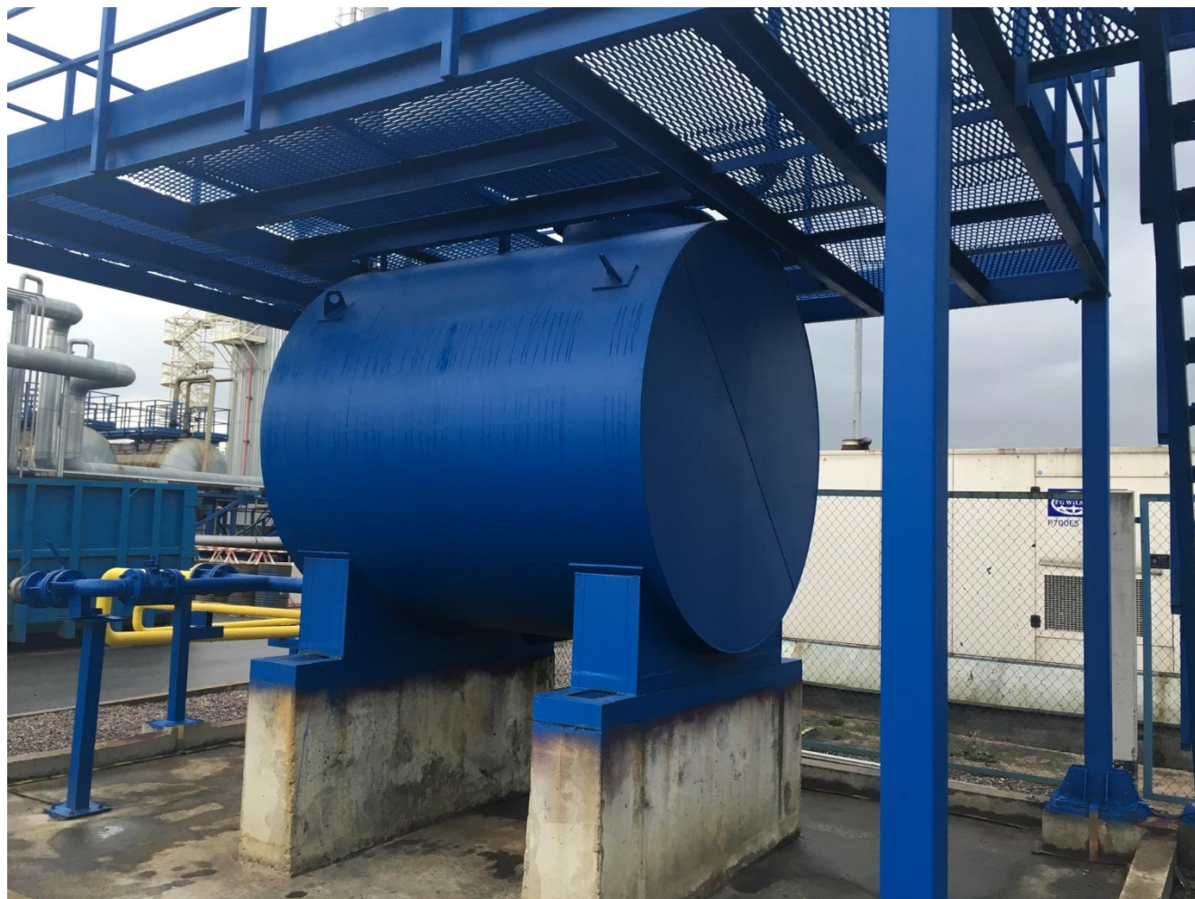
Рисунок 1 - Общий вид резервуара РГС-5
