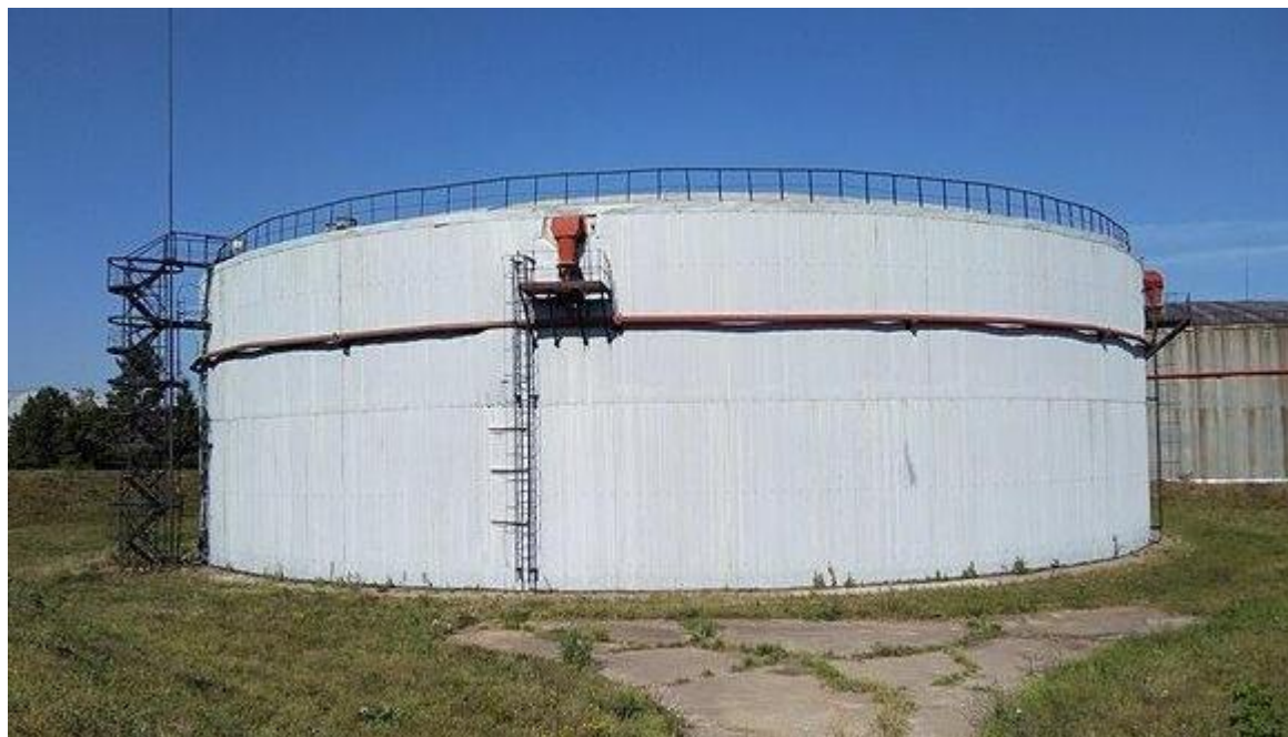
Рисунок 2 - Общий вид резервуара РВС-20000 № 3
