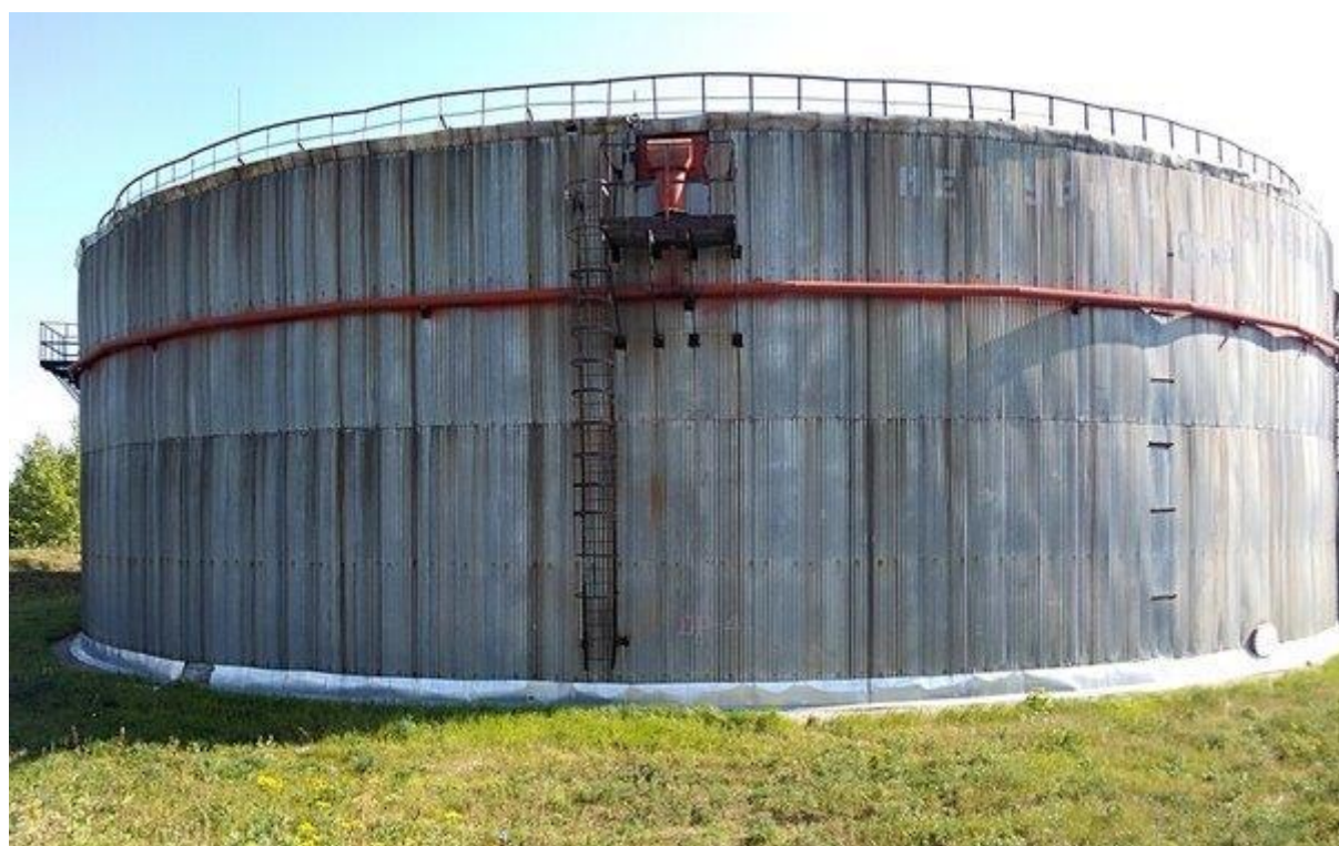
Рисунок 3 - Общий вид резервуара РВС-20000 № 4
