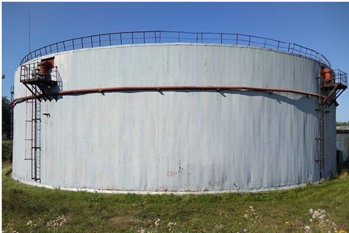
Рисунок 1 - Общий вид резервуара РВС-20000 № 2
