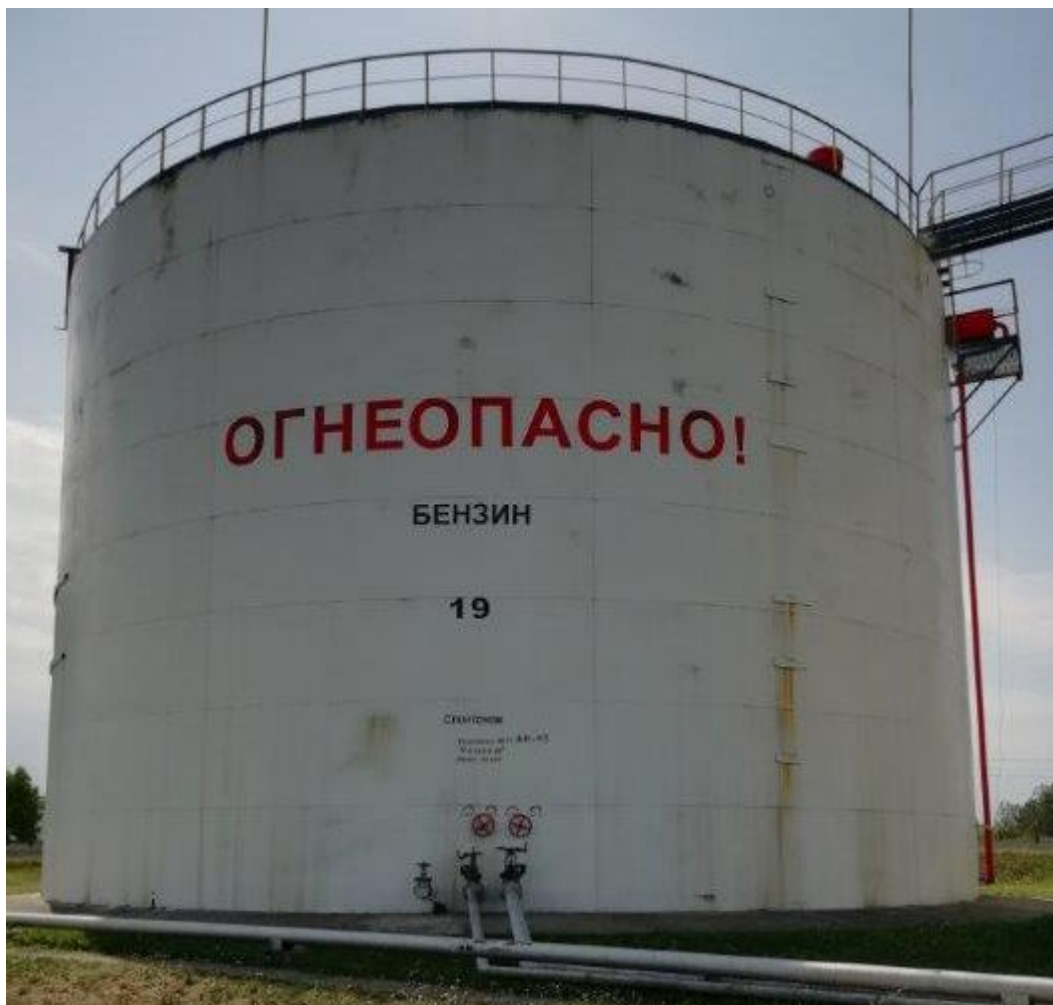
Рисунок 2 - Общий вид резервуара стального вертикального цилиндрического РВС-3000
