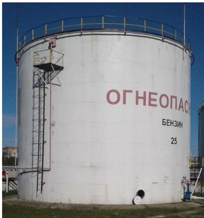
Рисунок 1 - Общий вид резервуара стального вертикального цилиндрического РВС-2000
