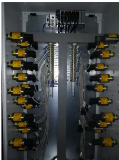
Рисунок 3 - Шкаф датчиков давления
