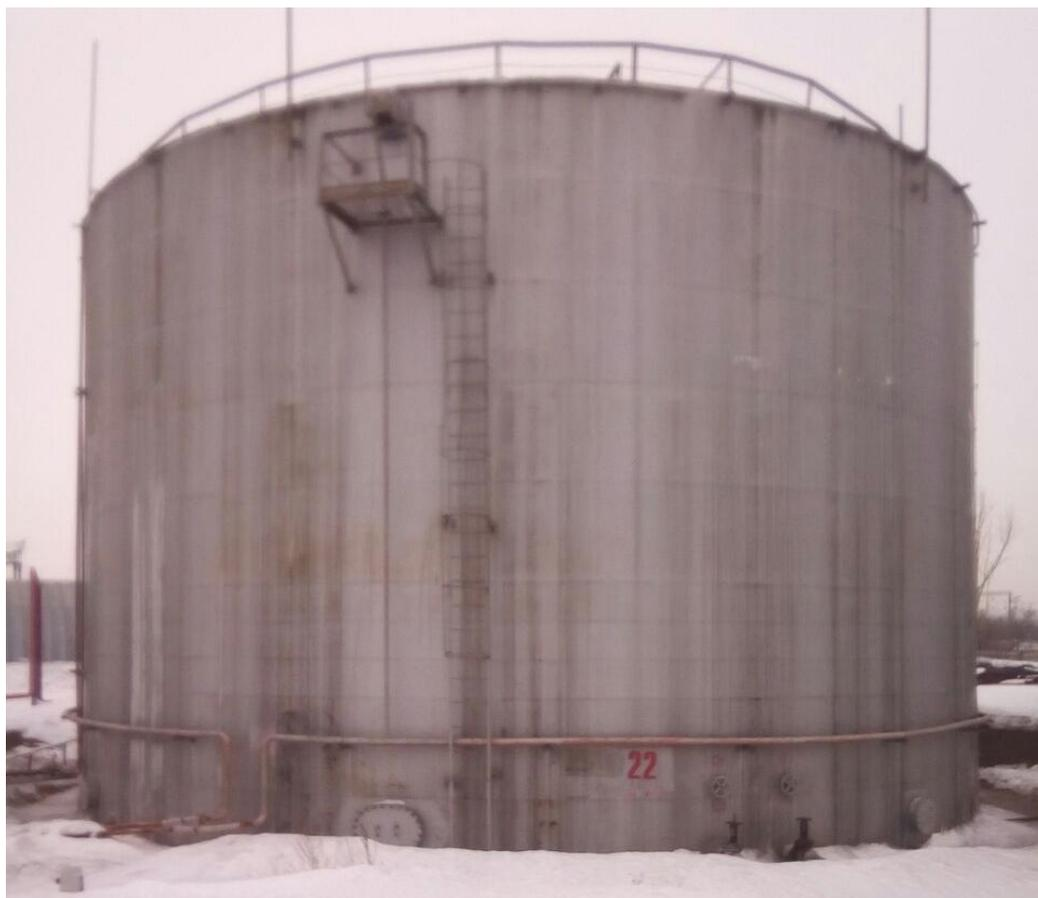
Рисунок 3 - Общий вид резервуара вертикального стального цилиндрического PVC-3000
