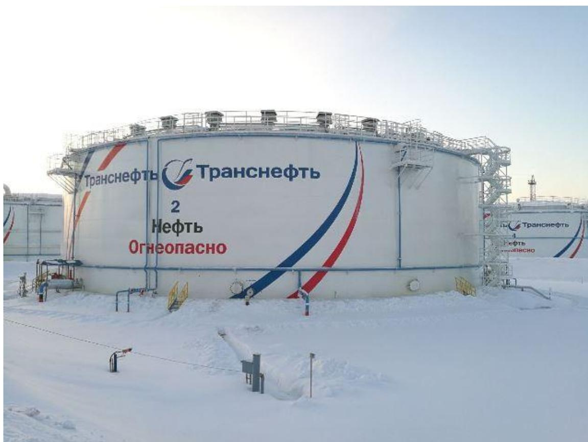
Рисунок 1 - Общий вид резервуара вертикального стального цилиндрического РВС-20000
