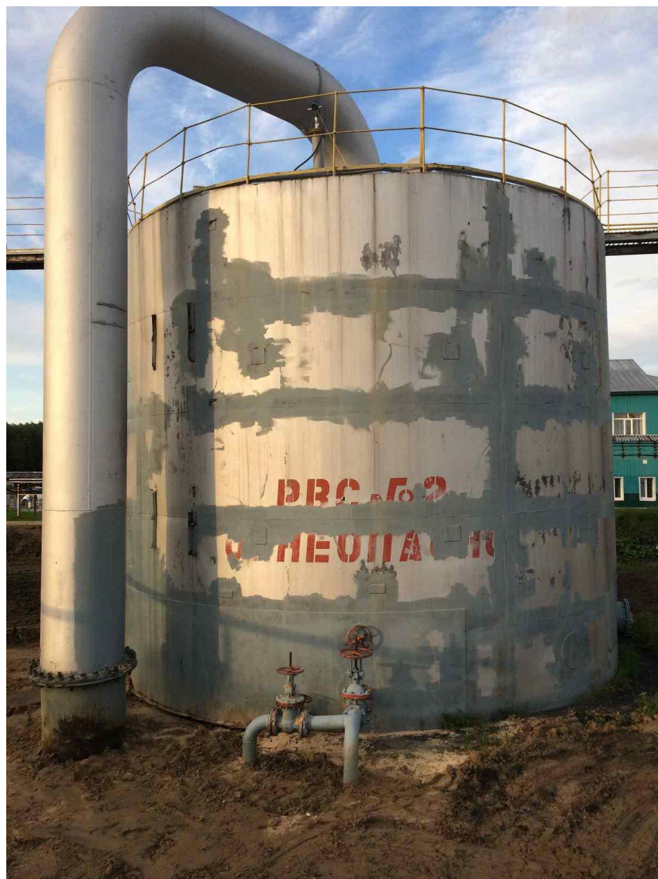
Рисунок 1 - Общий вид резервуара вертикального стального цилиндрического РВС-400
