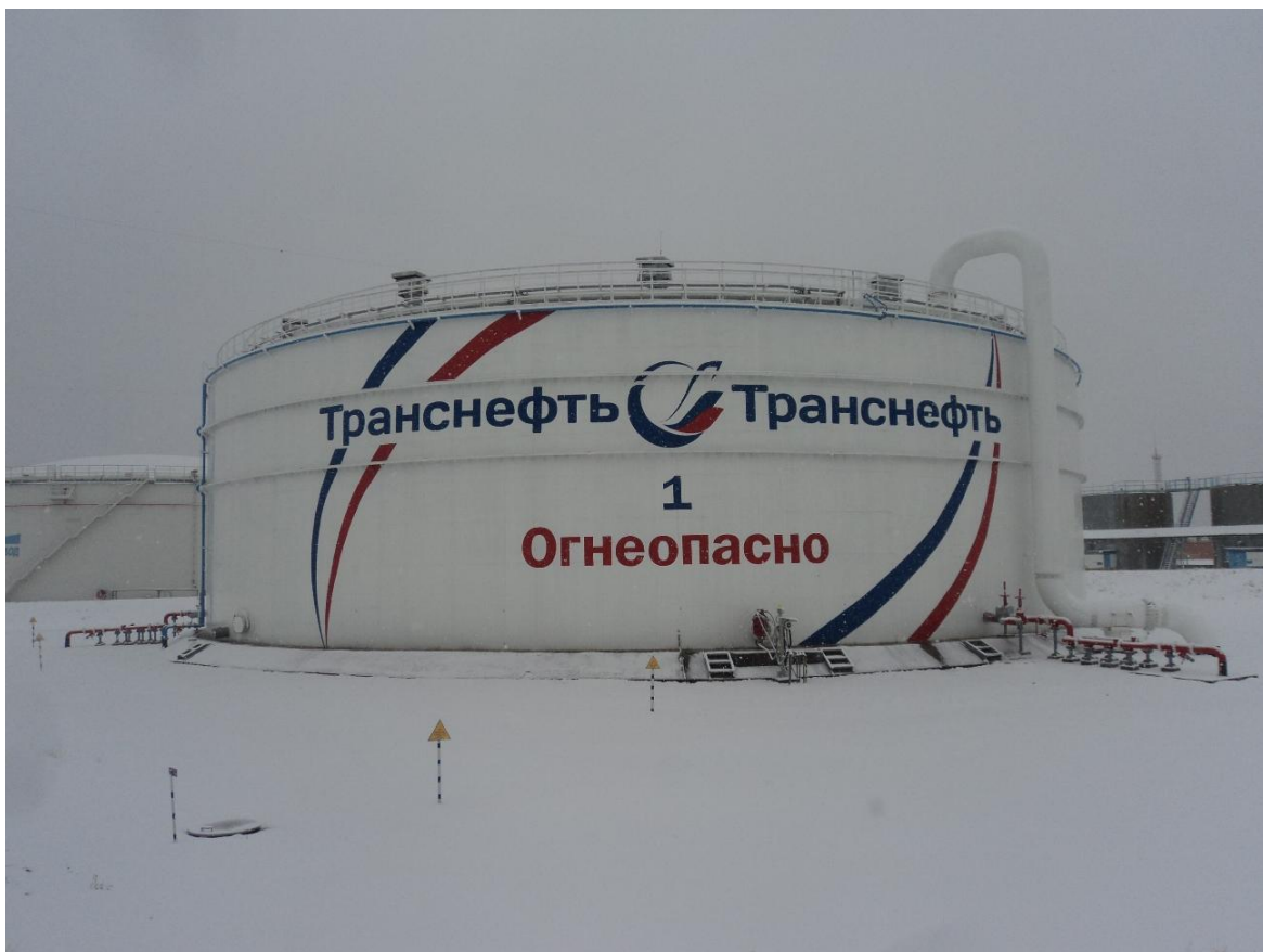
Рисунок 2 - Общий вид резервуара вертикального стального цилиндрического РВС-20000
