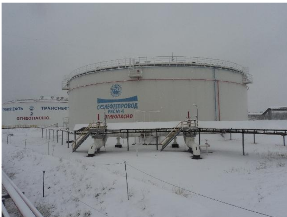
Рисунок 3 - Общий вид резервуара вертикального стального цилиндрического РВСП-20000
