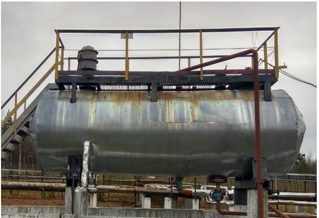
Рисунок 1 - Общий вид резервуара стального горизонтального цилиндрического РГС-20
