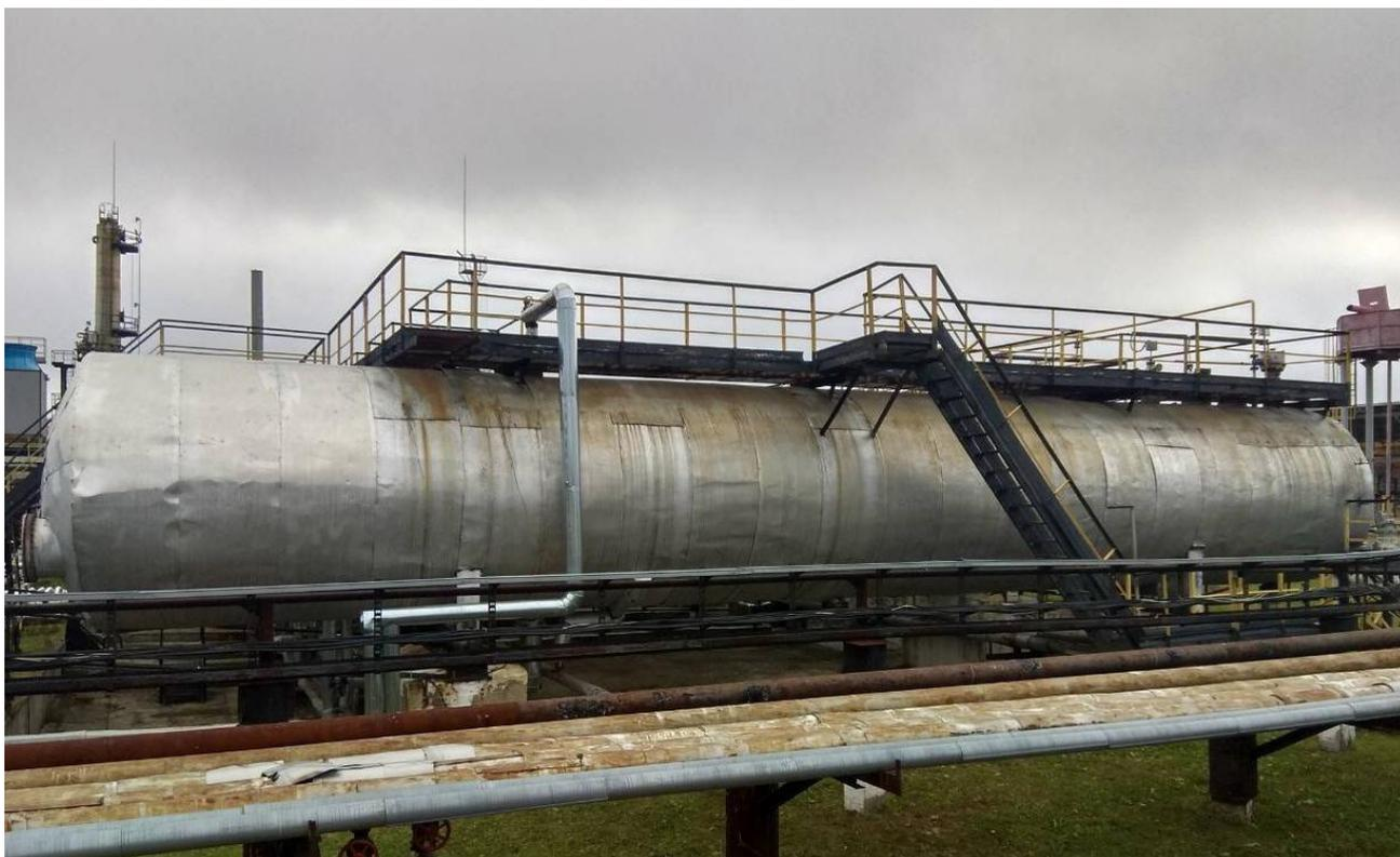
Рисунок 1 - Общий вид резервуара стального горизонтального цилиндрического РГС-200
