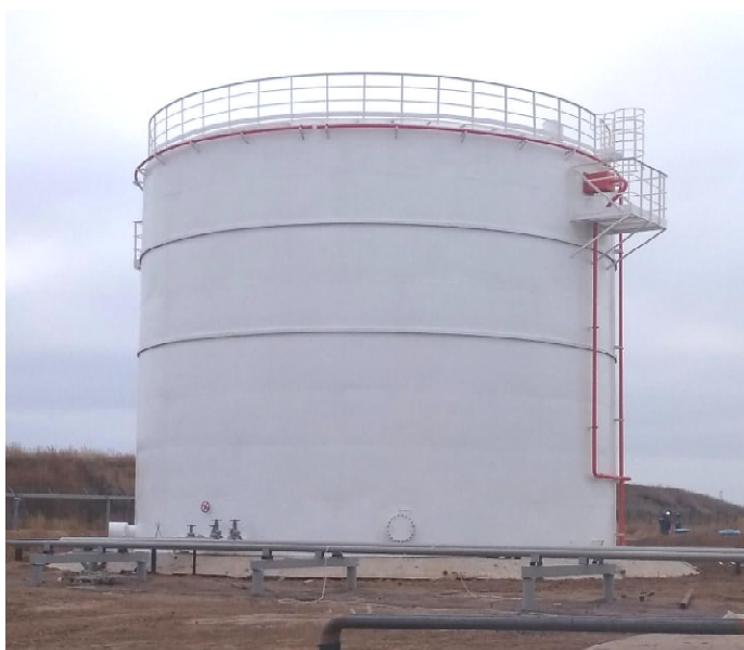
Рисунок 1 - Общий вид резервуаров РВС-3000
