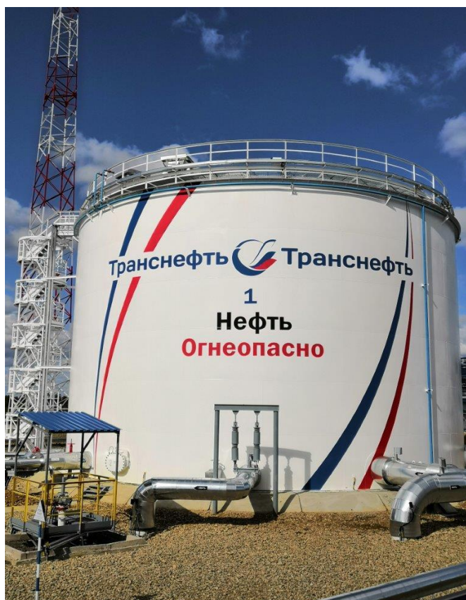
Рисунок 1 - Общий вид резервуаров вертикальных стальных цилиндрических РВС-3000
