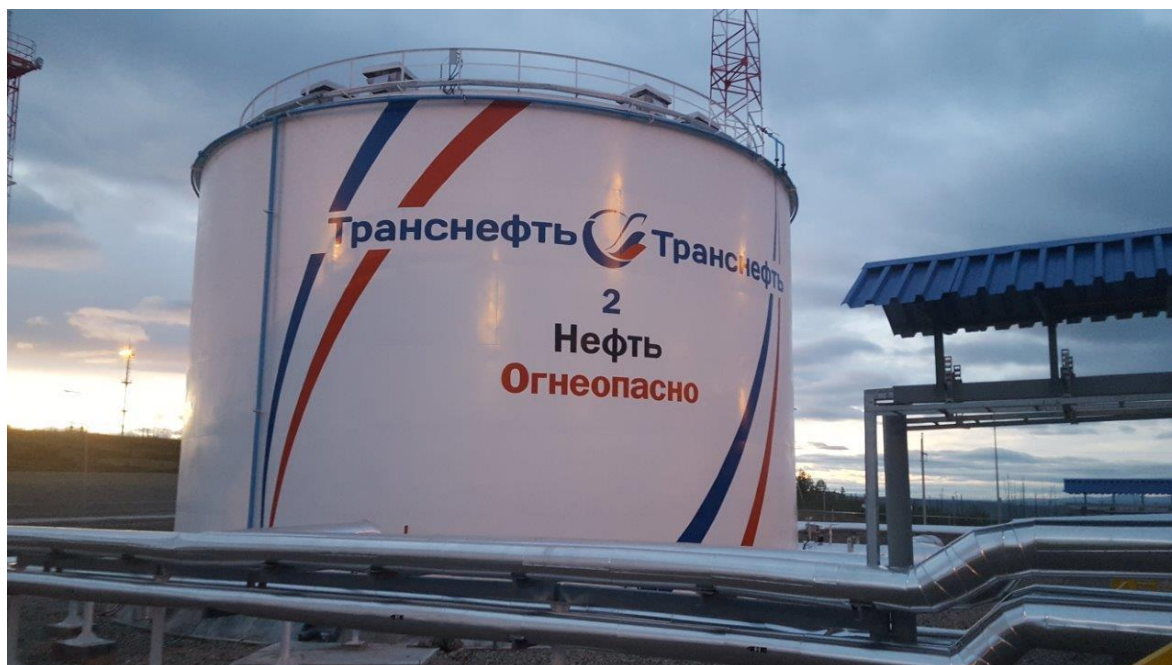
Рисунок 1 - Общий вид резервуара вертикального стального цилиндрического РВС-3000
